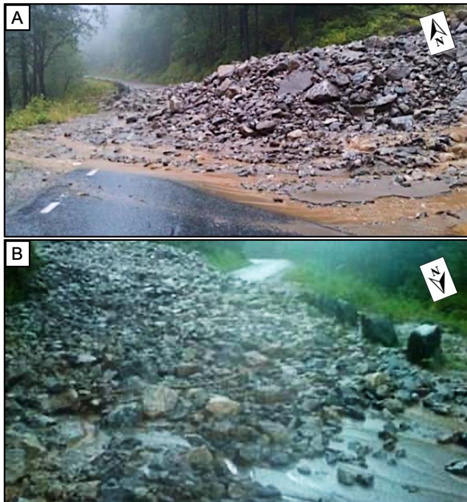
Figur 5.11: I august 2011 gikk det et flomskred på Svartøya. Flomavsetningene strømmet utover veien og ble avsatt i en 3 m høy skredtunge. A: Mye av de fineste sedimentene ble vasket ut og ført med vannet videre over veien og nedover mot Istra-elven. B: Skredtungen ble mye bredere enn skredløpet og skredet hadde maks utløpslengde ved nedre kant av veien. Foto: Gunnar Sandnes og Mikke Paulonen (Rødal et al., 2011).
