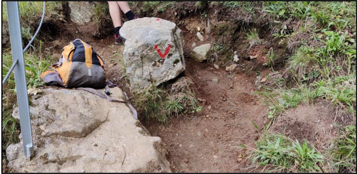
Figur 5.31: Lausmassane ved lokalitet 4 der det er avlese djupne- og breidde-målingar. Sekken på biletet er om lag 30 cm brei. Fotograf: Sindre Befring Hage.
