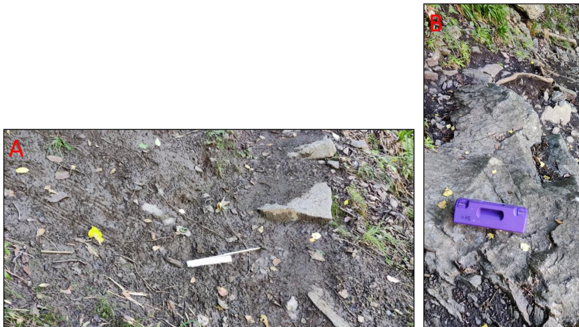
Figur 5.29: A: Lausmassane det er avlese djupne- og breidde-målingar frå, meterstokk om lag 21 cm. B: Blotningen det er avlese schmidthammarverdiar frå, meterstokk om lag 30 cm. Begge bileta er teke ved første feltundersøking. Fotograf: Sindre Befring Hage.
