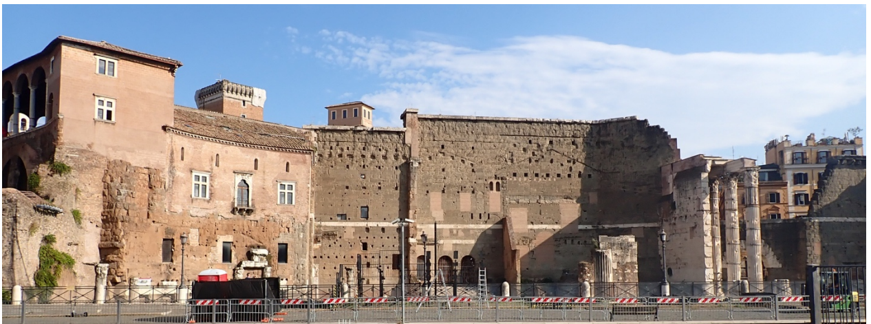
Figur 4 Brannmuren bak Mars Ultor-tempelet på Augustus' forum fra forumets sørvestlige halvdel. Til venstre er middelalderbygningen Casa dei Cavalieri di Rodi, bygd over forumets nordlige exedra.
