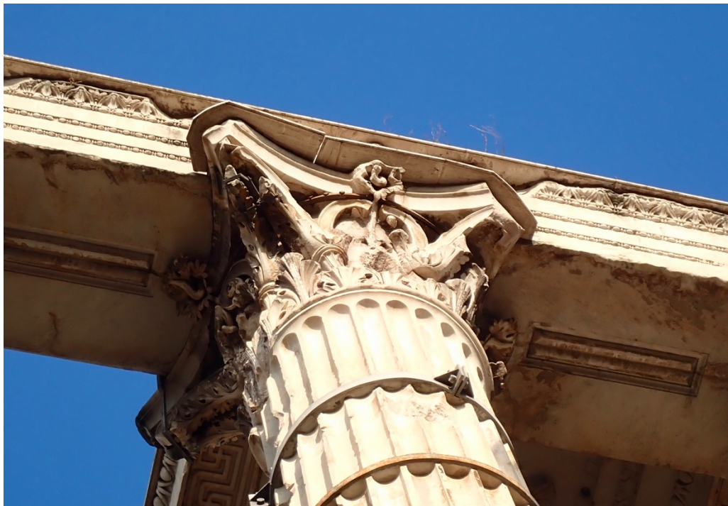
Figur 6 Korintisk kapitel i hvit Luna-marmor fra den eksterne søyleorden til Mars Ultor-templet.
