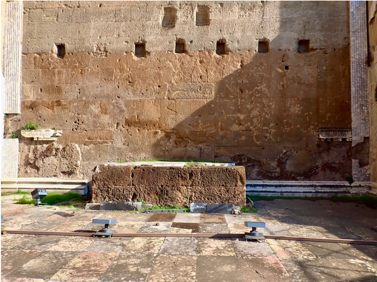
Figur 47 Kolosshallen, podium. Polykrom gulvlegging i rektangulære plater av giallo antico og pavonazetto.
