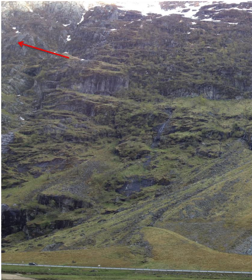
Figur 4.26.5: Oversiktsbilde tatt fra vestre dalside. Her kommer begge skredvollene godt frem. Et belte av blokker kan ses der disse møtes
