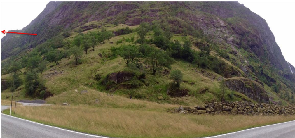
Figur 4.22.3: Oversiktsbilde over lokaliteten. Eldre oppmurt skredvoll kan ses nede i høyre hjørne, og området foran lokaliteten som har blitt endret under veitbygging. En person står midt på viftens sørlige flanke. Foto: Sofie Bakkevig Valheim. Fotopunkt 1 i Fig. 4.22.1
