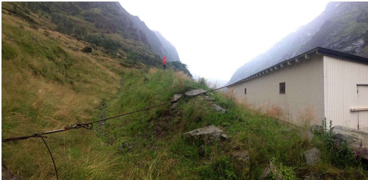
Figur 4.32.4: Skredvullen og forsterkningen bak geitefjøset. Den bratte gradienten oppover kan ses på bildet. Bilde er tatt fra nord mot sør. Fotopunkt 1 i Fig. 4.32.1
