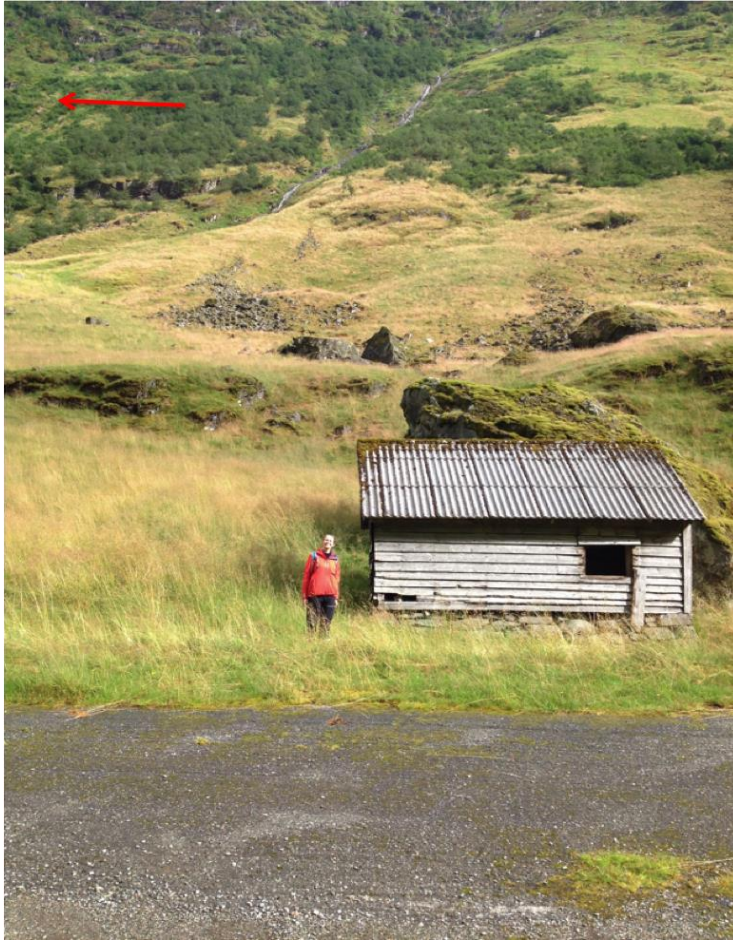
Figur4.34.3: I forgrunnen kan den tidligere hovedveien ses. Huset er bygget bak den store blokken for å gi beskyttelse for skred. I bakgrunnen kan flere store blokker ses. Disse har trolig blitt dempet av grunnfjellet under som gir et ujevnt terreng. Fotopunkt 1 i Fig.4.34.1
