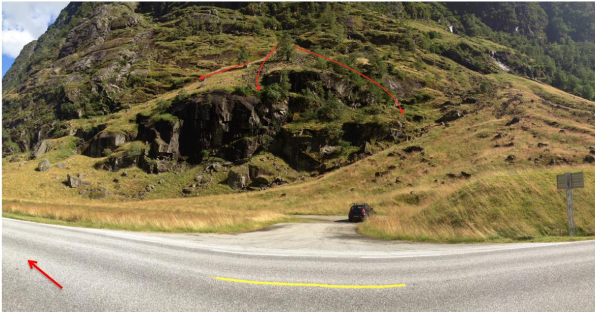
Figur 4.27.6: Panoramabilde over lokaliteten. Skredavsetningene som ligger over den eksponerte fjellblotningen har flere steder falt ned og lagt seg blant steinsprangblokkene. Pilene på bildet viser de ulike retningen blokker og snø muligens trolig har tatt
