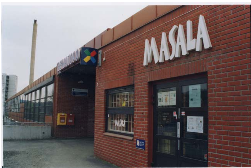
(Foto 3: MASALA håndarbeidsverksted. Pipa til Fjell fyrings- og servicesentral i bakgrunn.)
