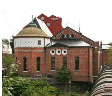
Fritzøe elektrisitetsverk fra 1901 (12,9GWh 3,3MW). Foto: Lars Mæhlum
