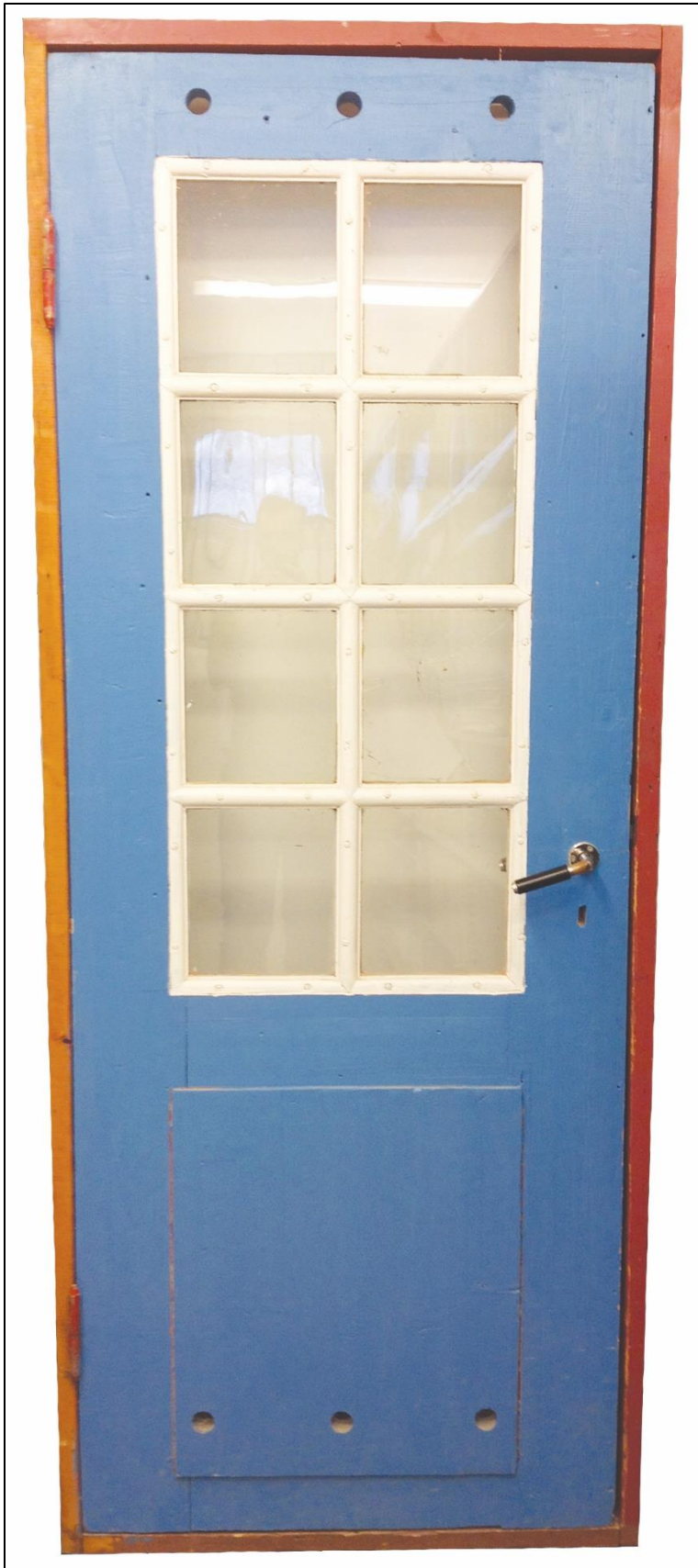
Vedlegg 6: Dør fra særavdelingens sovecelle, med luftehull.
