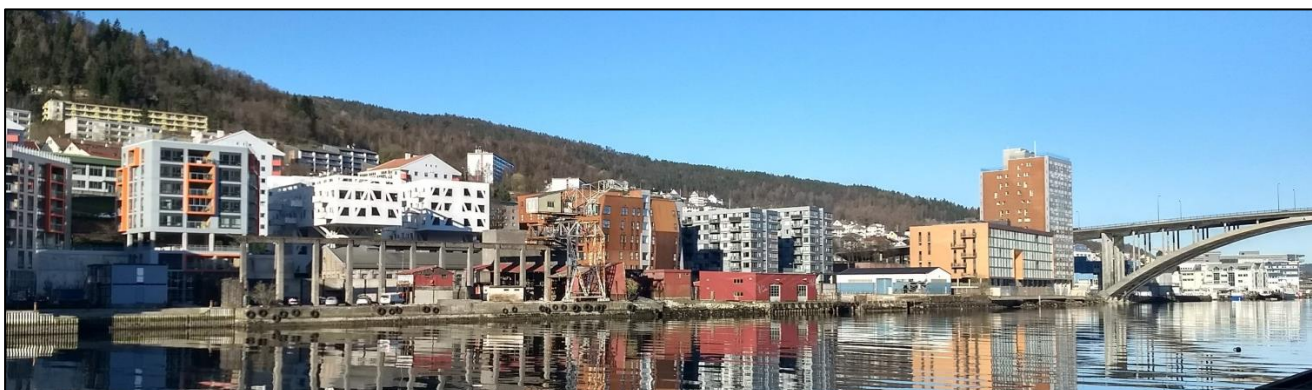
Fig. 102. Damsgårdsveien nord i 2019 (Eget foto, 2019)
