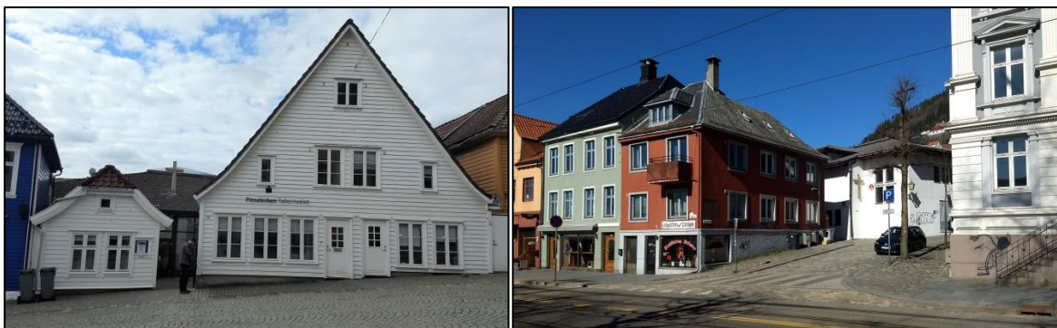
Fig. 83 og 84. Den nyere bygningen er nesten skjult blant husene rundt (egne foto, 2019)
