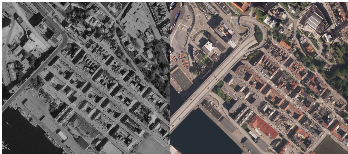
Figur 2.7 – Før og etter utvidelsen av Puddefjordsbroen, 1980 og 2016 (Datagrunnlag: Norge i bilder, november 2019)
