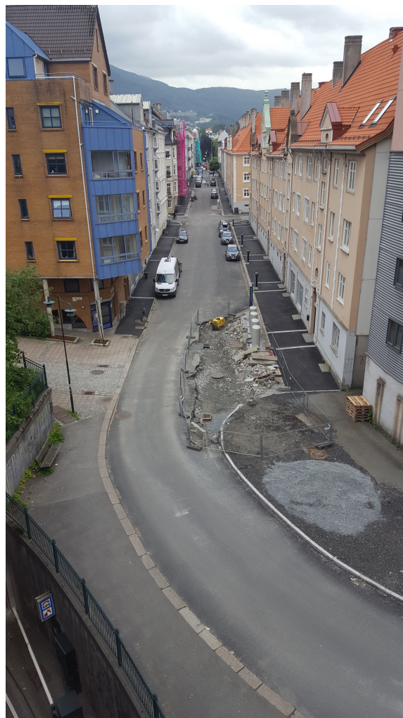
Figur 7.6 – Professor Hansteens gate. Anleggsarbeidet gjøres i forbindelse med etablering av bossnettet og medfører innsnevring av veibanen (Foto: privat)
