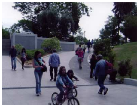
Fig 15 Inngangsparti til Evangelismos stasjon
