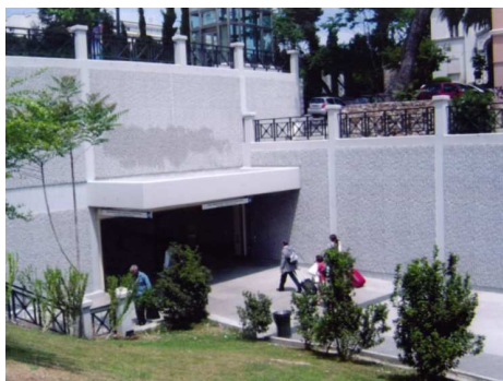
Fig 14 Metroeksteriør Evangelismos stasjon
