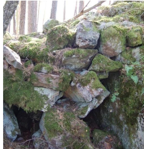
Figur 14: Detalj av kløftmur
