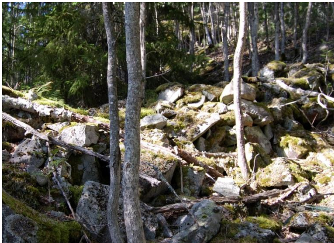
Figur 12: Østre kløftmur i ytre murverk
