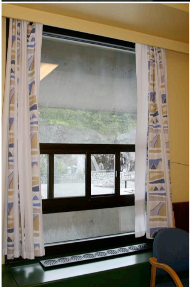
Bilete 7-8: Etsing inn i vindaugsflata, sett frå rom mot aust i Sentralblokka.
