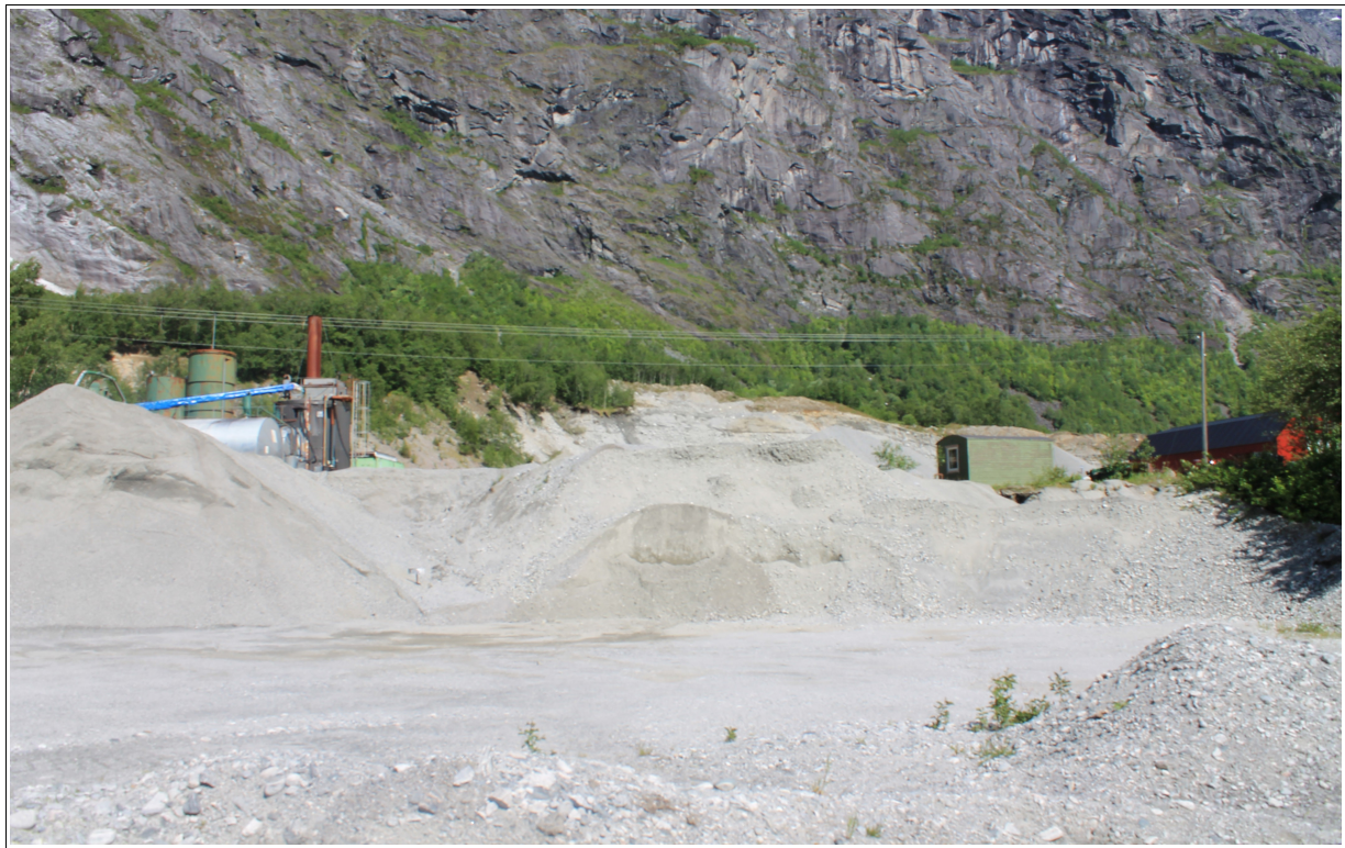
Figur 13: Grustaket som er lokalisert ved gårdstunet på Horgheim er enda i bruk. Foto: Tone B. Lysgård
