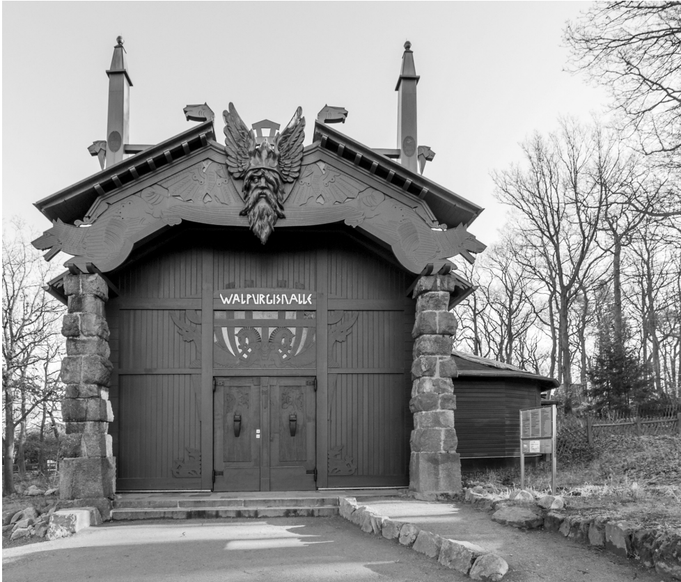
Fig. 1. Walpurgishalle, Thale, exterior 2018 (© User: Matthias Süßen, https://commons.wikimedia.org/wiki/File:Hexentanzplatz_Thale_msu2017-0633.jpg – accessed: 20 December 2018).
