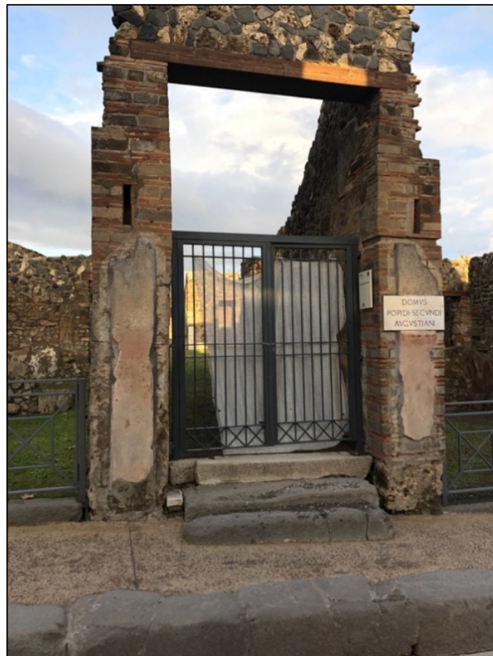
Figur 11: Døråpning til domus, I.iv.5 (Forfatter)
