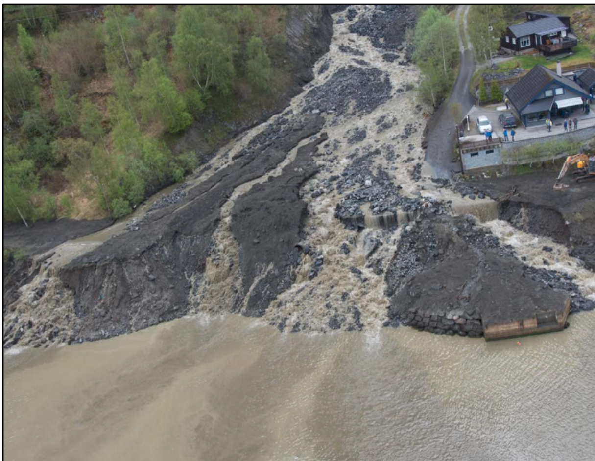
Figur 3.8: Skredløpet over fv5625 (Statens Vegvesen, 2013).
