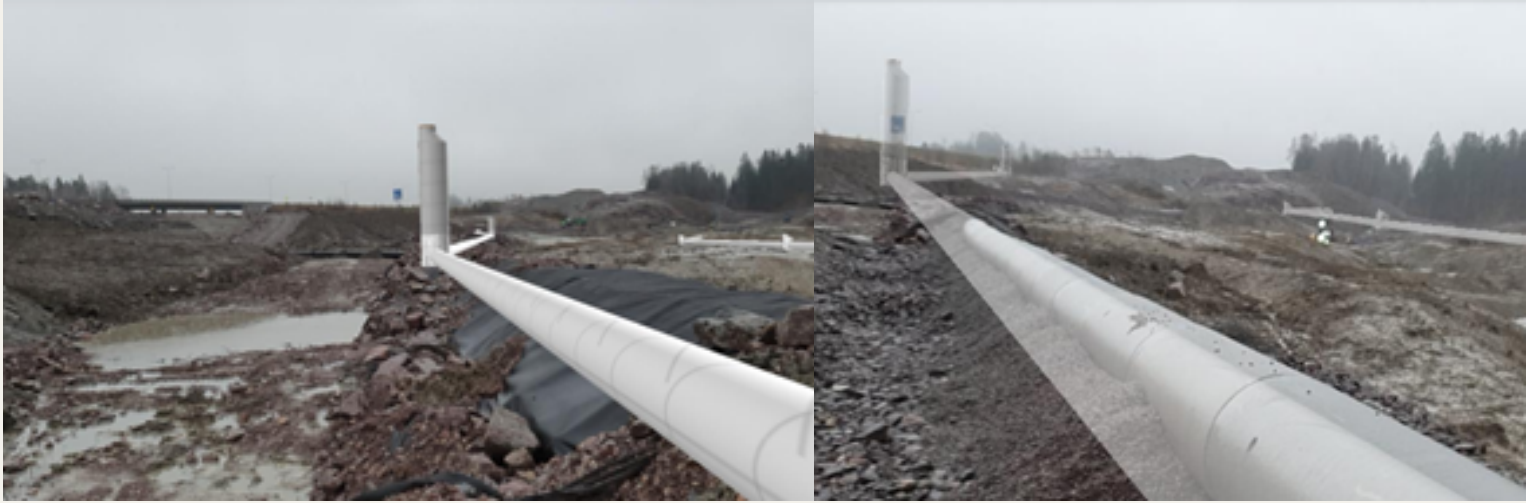
Samme rør, to vinkler sett i TSV
