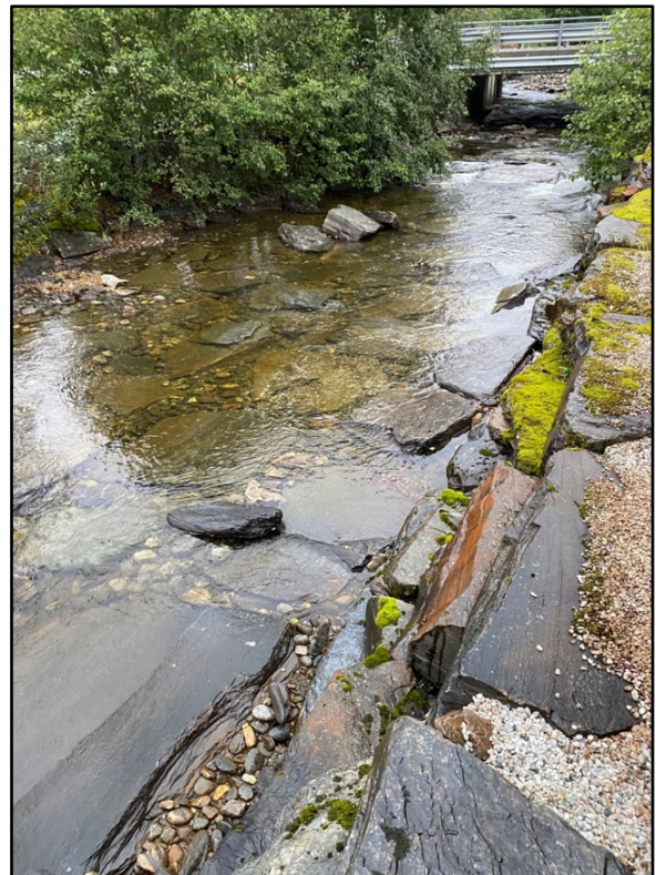
Figur 14: Erosjonskontrollerende tiltak i nedre del av Sundsvåselvi.
