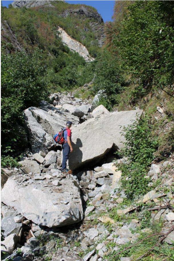
Figur 5.9.2 Store, ferske blokker ved del-lokalitet 9.1.1 og synlige, ferske slippsoner i fjellet over.
