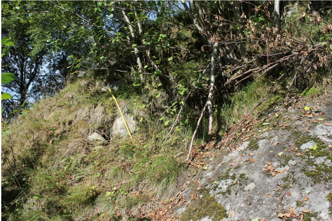
Figur 5.6.3a: Bekkeløpet ved del-lokalitet 6.1.2 har vegetasjonsdekkede vegger av blokker i finmateriale, og bart fjell som er blottlagt. Målestokken er 1 m.
