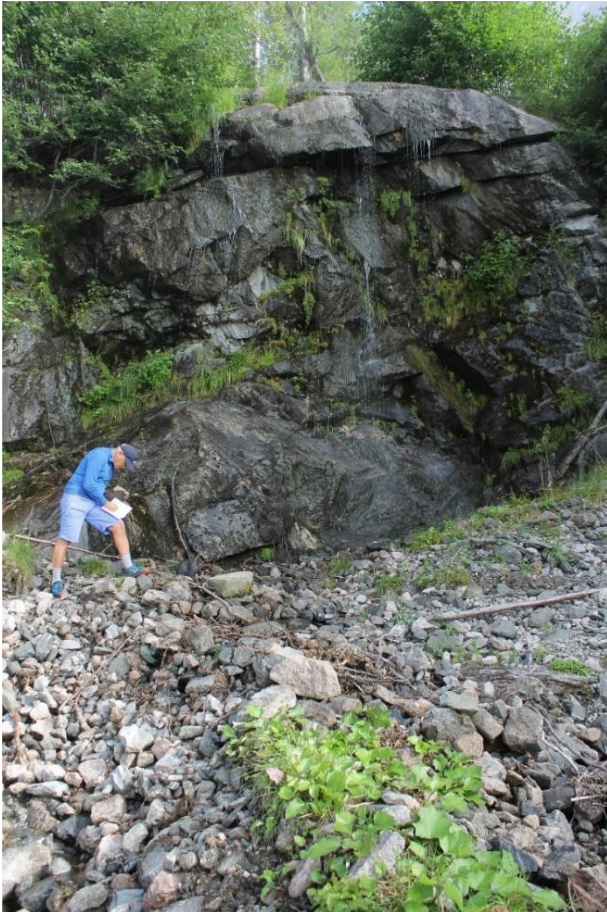
Figur 5.6.2 Bart fjell og foss over skredoverbygget ved del-lokalitet 6.1.1.
