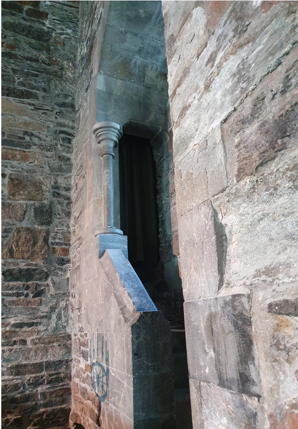
Fig.11: Dybvikstrand Eidem, O.K, 2022, Inngang til gonger i muren bak høgsetet
