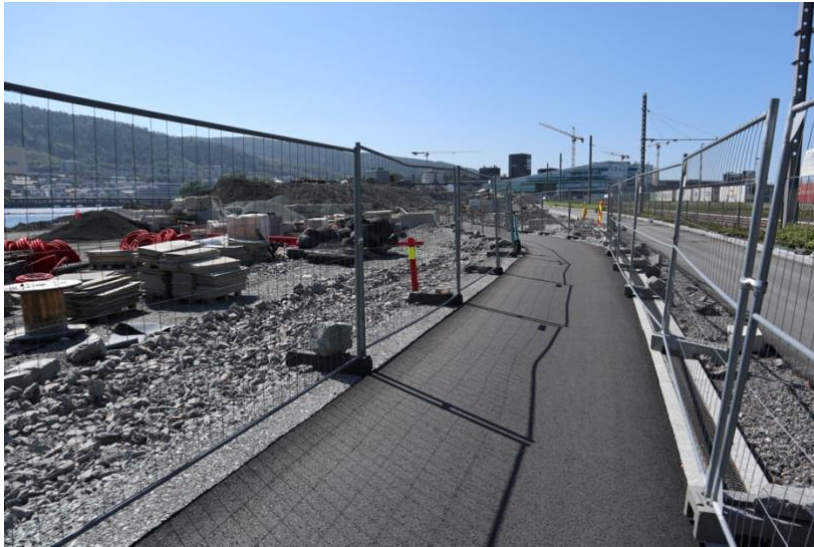
Bilde 6: midlertidig gang- og sykkelvei hvor den nye parken skal bygges, juli 2021. Kilde: Lene Drengenes
