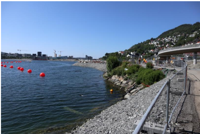
Bilde 5: området for bystrand og ny Lungegårdspark under utbygging, juli 2021. Kilde: Lene Drenge
