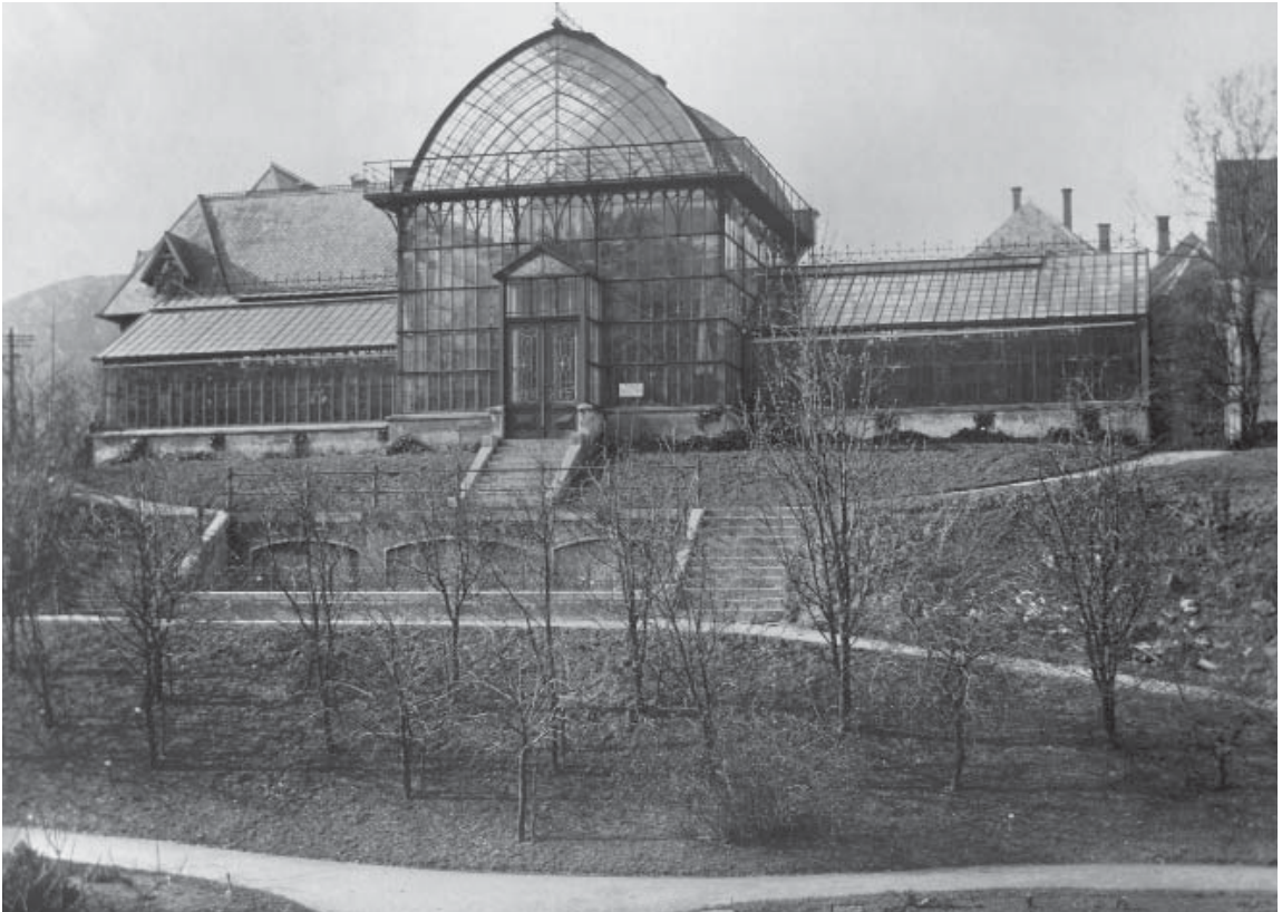
Plantehuset mellom 1912 og 1915. I bakken nedenfor ses et større antall små trær i rosefamilien, de aller fleste rogn og asal i slekten Sorbus. Armauer Hansens byste som sto her, ble flyttet etter hans død i 1912, men en kan fortsatt skimte merket i plenen foran trærne i fremste rekke til venstre i bildet (ukjent fotograf, Universitetsmuseets fotoarkiv).
