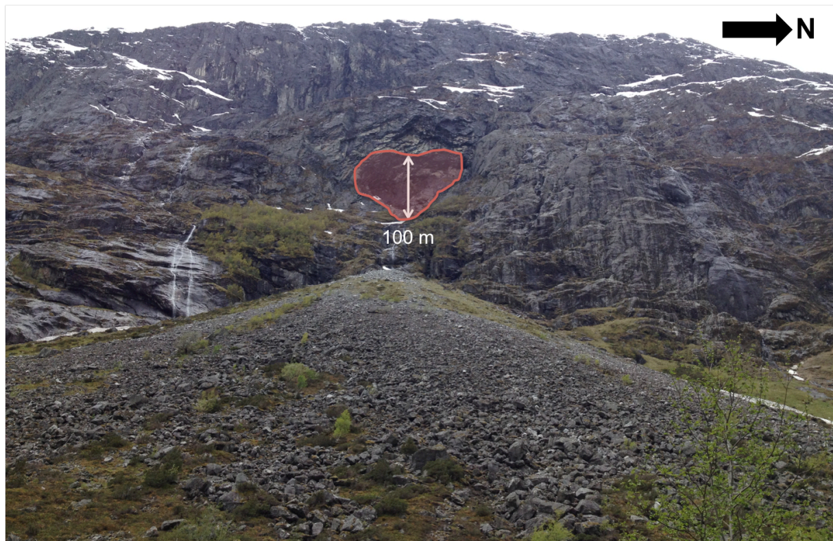
Figur 7.1.4: Steinsprangviften ved lokalitet 11 og et 100 m høyt skredarr. Utløsningsområdet er innlysende og ligger like over viften. Det er betydelig eksfoliasjon i og rundt skredarrret.
