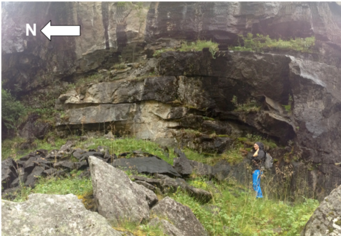
Figur 5.2.1: Bildet er tatt ved lokalitet 29, se lokalitetskart i figur 6.1. Personen på bildet er 1,67 m høy. Fjellet har tydelige horisontale sprekker og danner kubiske blokker (Foto: Sofie Bakkevig Valheim, 2015).
