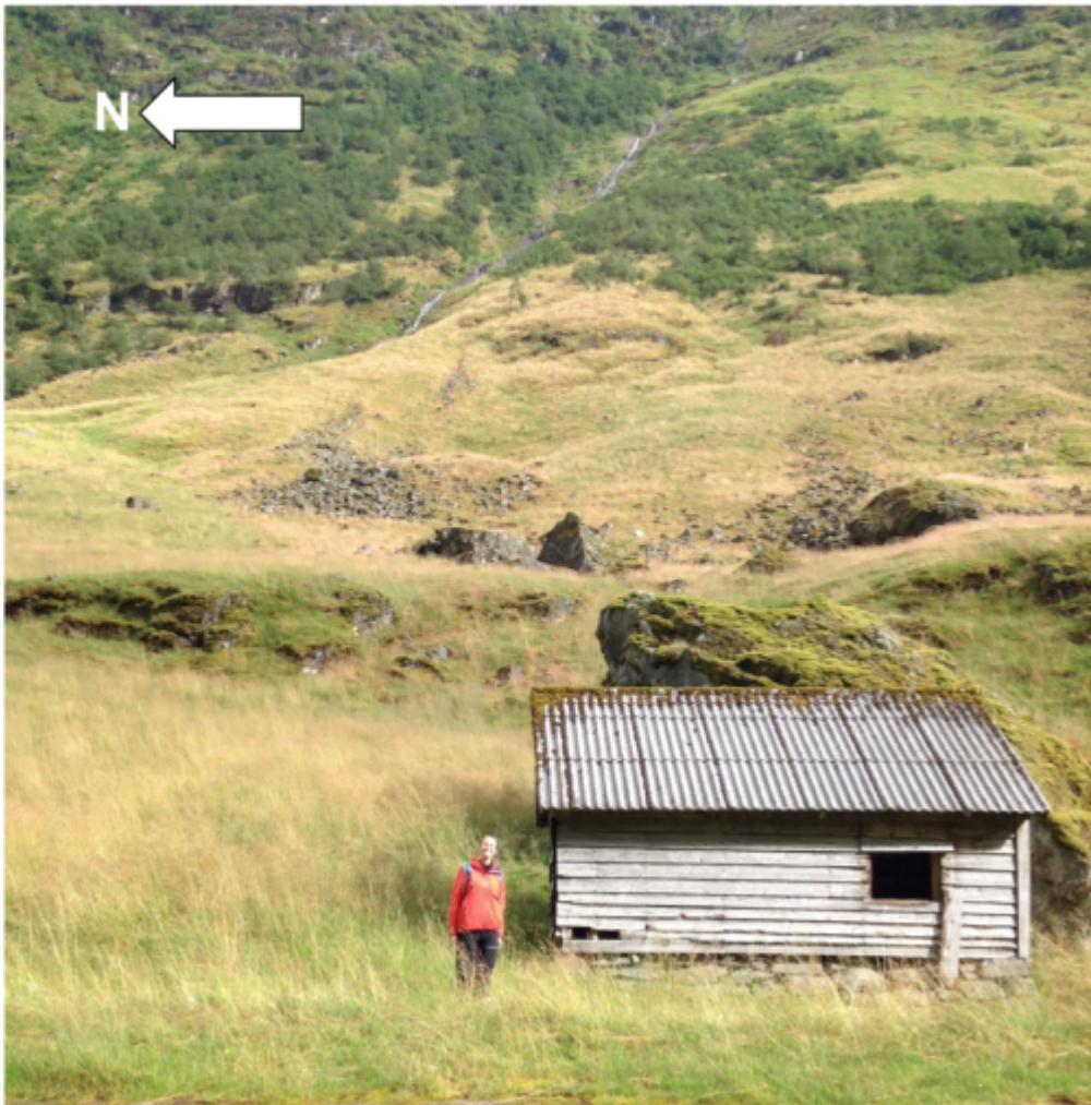
Figur 7.1.10: Dette skuret ved lokalitet 36 er bygget like foran en stor skredblokk. Dette er et tiltak for å sikre at skuret ikke skal bli skadet av fallende blokker.
