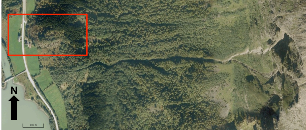
Figur 2.1.2: Oversiktsbilde over Bergheim. Den røde firkantet markerer skredmassene som er undersøkt. Her er det bygget hus like foran skredavsetningene. E39 går like nedenfor. Det er et tydelig skredarr på toppen av fjellsiden.
