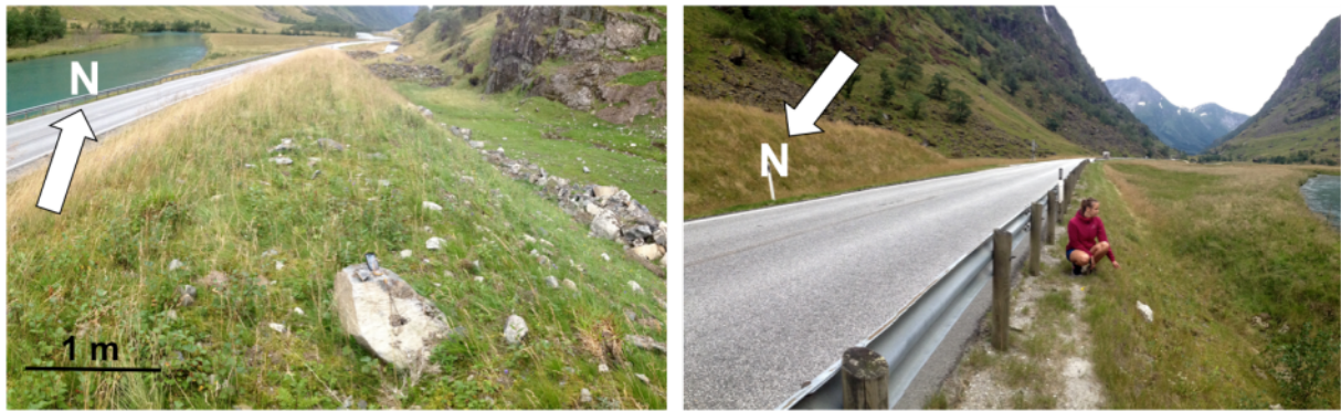
Figur 7.1.8: Bildet til venstre viser blokker og mindre steiner som ligger på toppen av skredvollen. E39 strekker seg nede venstre for skredvollen, og til høyre kan en se større skredmasser som ligger samlet bak vollen. Bildet til høyre viser skredvollen til venstre, E39 og her pekes det på blokken som er falt over veien og autovernet.
