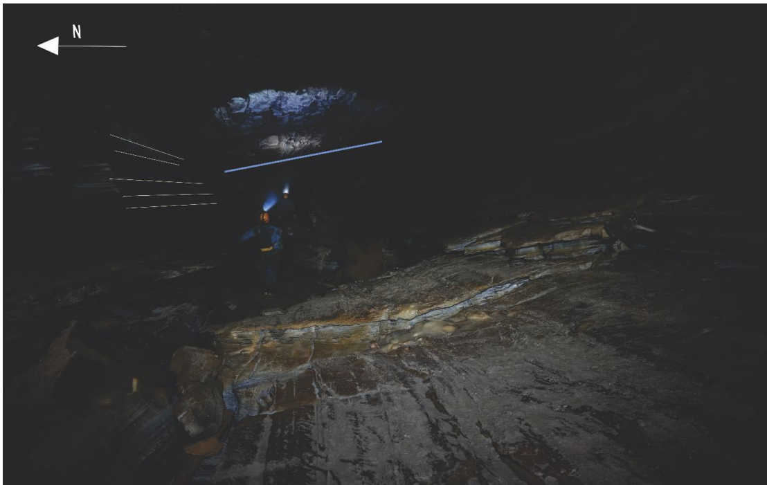
Figur 4.13: Bilde av tunnelens typiske morfologi. Her uten den veldig tydelige bekløpsnedskjæringen som observeres i noen partier. Mulig ledespalte mot taket markert med blå strek. Folasjonen er markert med gul strek. Personer som skala. Foto: Alexander G. Stadheim.
