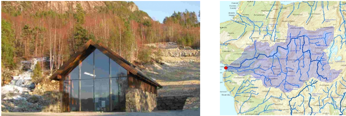
Figur 8 viser kraftstasjonen ved Årvik til venstre, og det tilhørende nedbørfeltet til høyre.[15]
