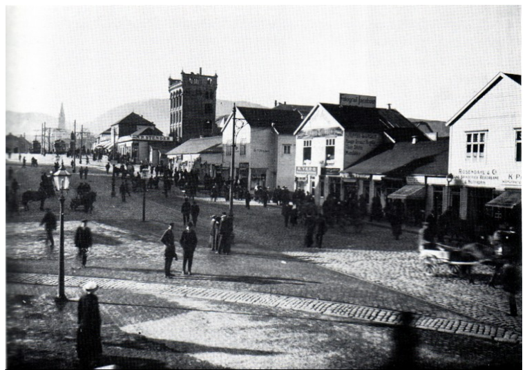
Bildet viser midlertidige brakker og bygninger for butikker og kontorer som ble satt opp like etter bybrannen. Foto: O. Svanøe.
