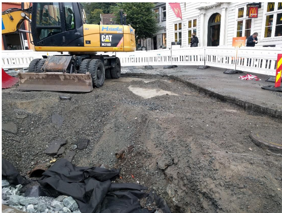
Figur 3-4: Eksempel på hvordan de øverste antropogene løsmassene i Bergen sentrum kan se ut. Bildet viser fyllmateriale avdekt under gravearbeid i Bryggesporden mellom Vetrilidalmeningen og Kong Oscars gate. Fyllmaterialet består hovedsakelig av grus og stein.
