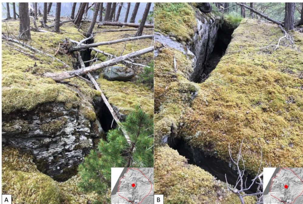
Figur 7.16 Bilde A og B viser oppsprekking langs skrent. Sprekken i A viser trær som velter ned. Sprekker på bilde B avgrenser en blokk fra fast fjell.
