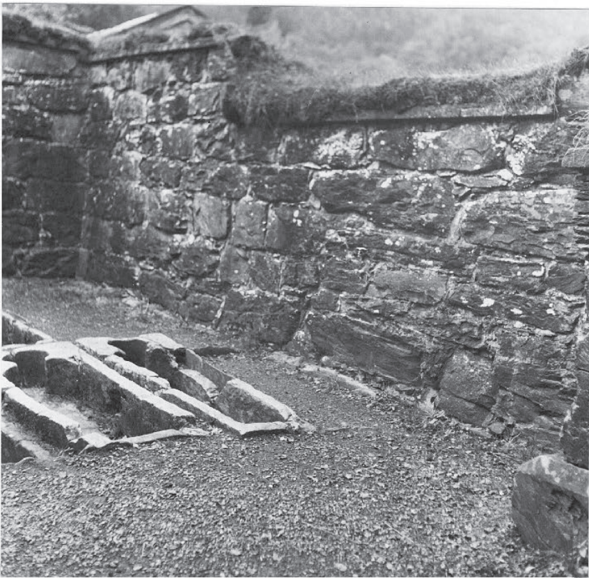
Fig. 36: Nordre kapell, nordmur og del av vestmur, indre murliv.
