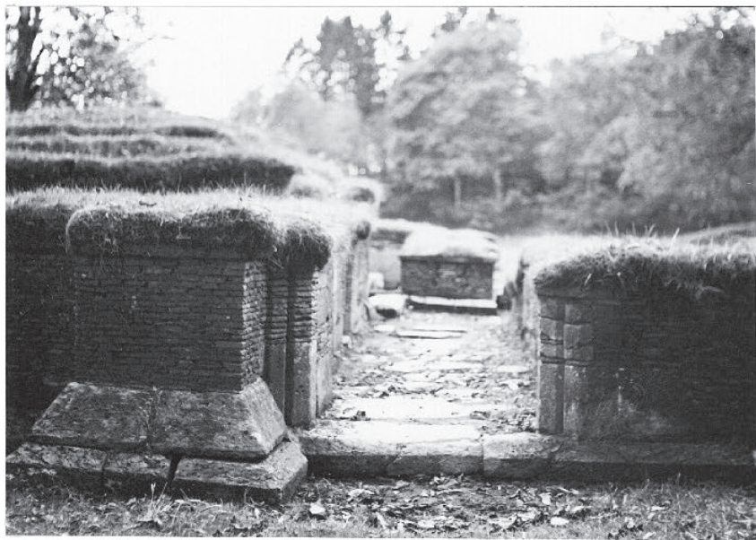
Fig. 131: Østpassasjens portal, sett fra øst.
