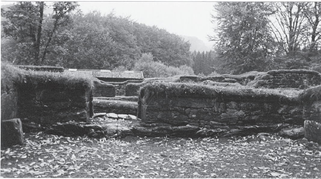
Fig. 196: Refektoriets nord- mur, indre murliv, østre del.
