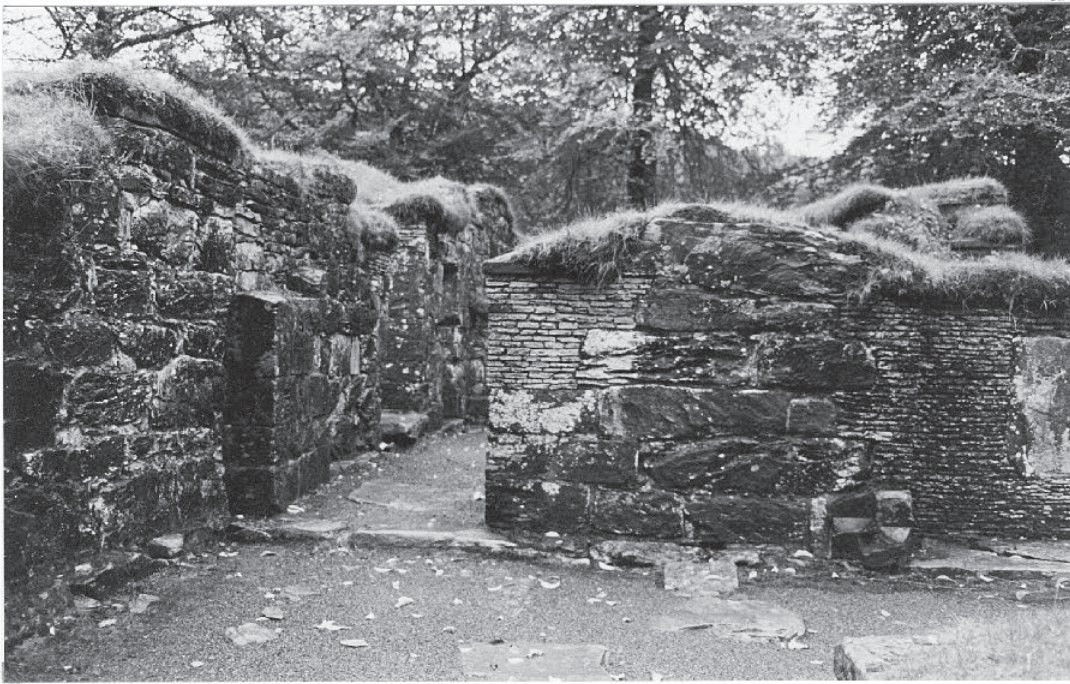
Fig. 61: Søndre kapell, vestmurens døråpning, ytre murliv.
