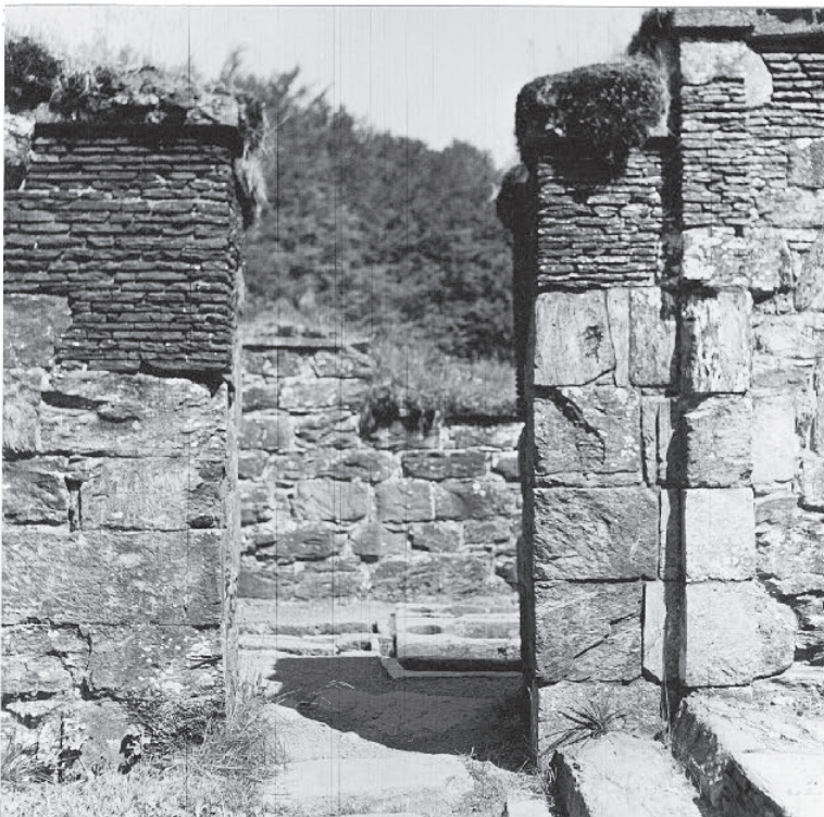
Fig. 63: Inngang fra presbyteriet til nordre kapell, sett fra presbyteriet.
