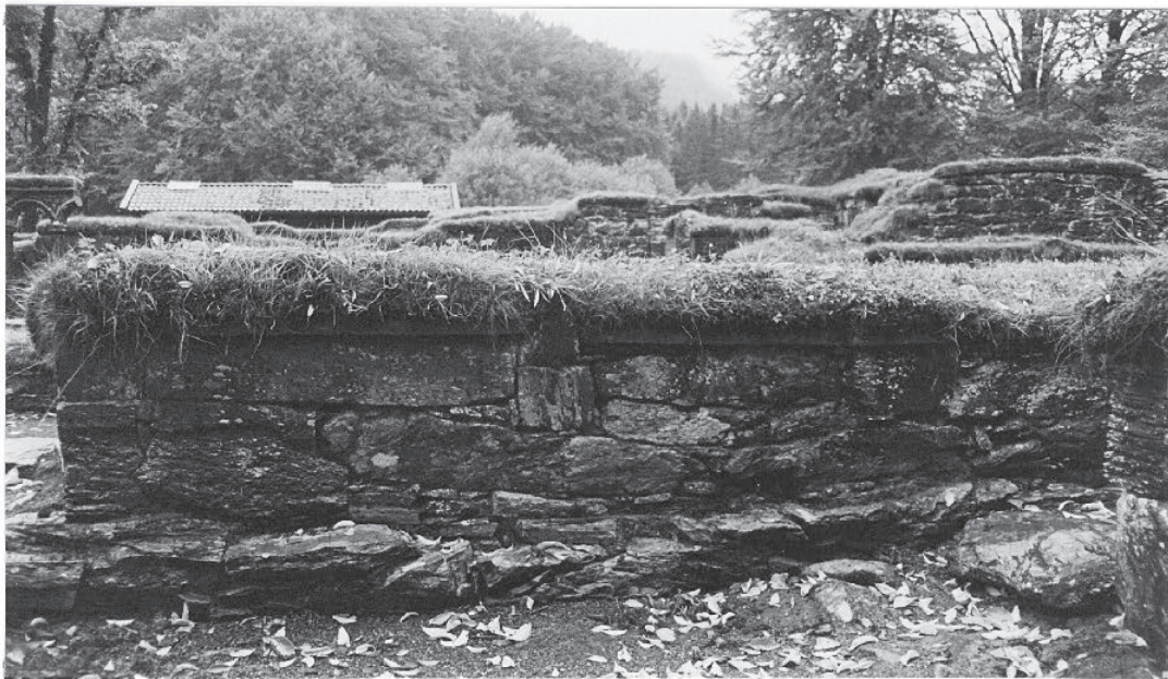
Fig. 200: Refektoriets nordmur, indre murliv, østre del, med gjenmurt åpning.
