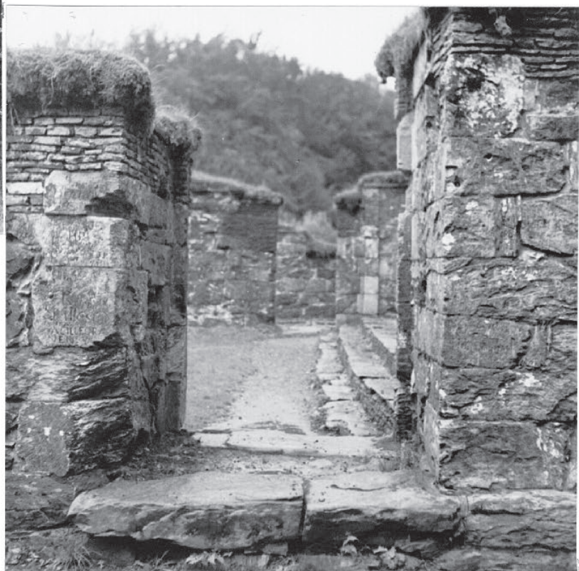
Fig. 66: Inngang fra presbyteriet til søndre kapell, sett fra søndre kapell.
