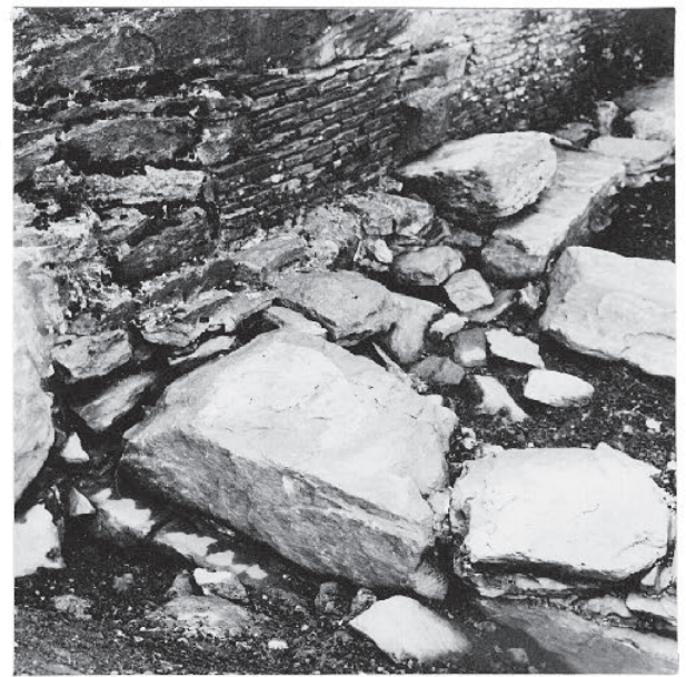
Fig. 191: Østre del av samme fundament, sett fra nord.
