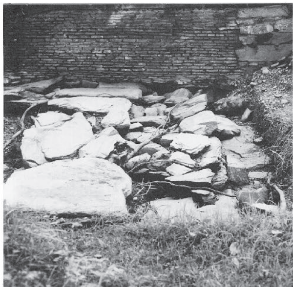
Fig. 180: Det vestre fundamentet, sett fra sør.
