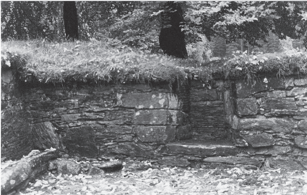
Fig. 197: Refektoriets sør- mur, indre murliv, østre del.
