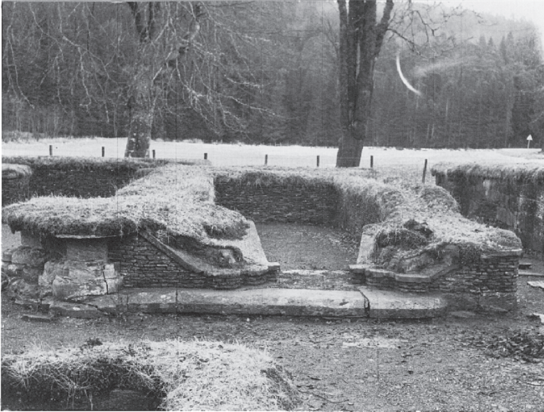
Fig. 117: Parlatoriet, inngangspartiet mot vest.
