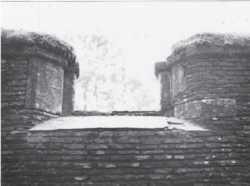
Fig. 76: Søndre kapell, østmur med rester av vindu, ytre murliv.
