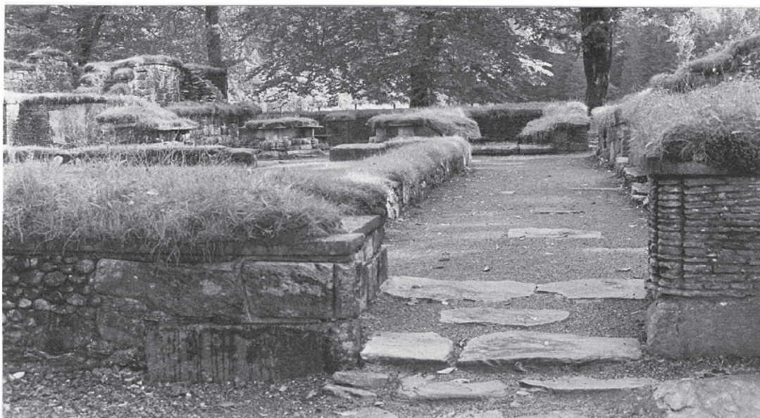
Fig. 224: Den vestre inngangen til korsgangen, sett fra vest.
