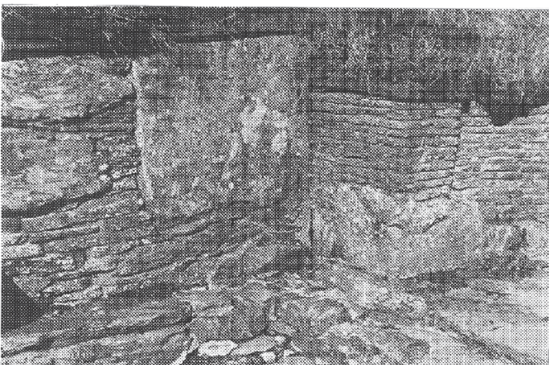
Fig. 210: Legbrødrenes refektorium, n/ø hjørnet (indre murliv).
