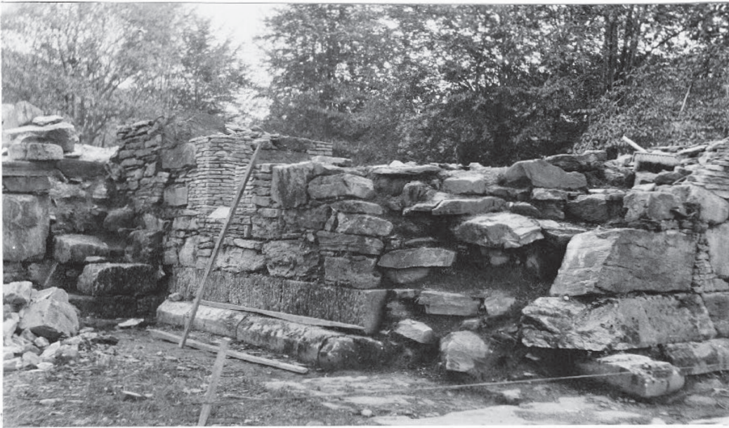
Fig. 135: Dagrommet, s/v hjørne med vestmuren, ytre murliv. Foto 1920-årene. Neg. Riksantikvaren.
