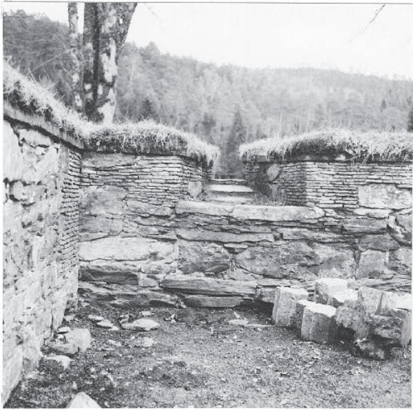
Fig. 144: Dagrommet, østmurens nordre del med rester av vindu, indre murliv.
