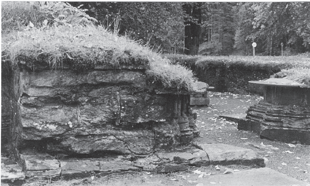
Fig. 111: Kapittelsalen, nordportalens nord- vange mot tilstøt- ende murliv, ytre murliv.
