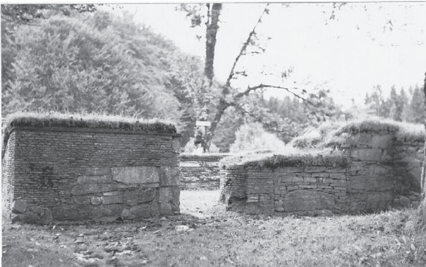
Fig. 27: Kirkens to vestre sørportaler, hvorav den østre nå er gjenmurt. Ytre murliv.
