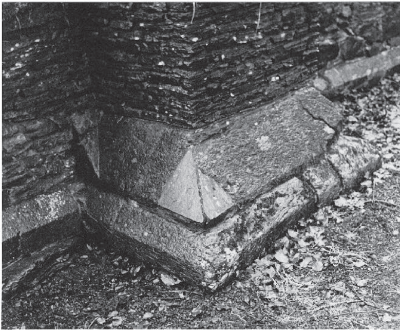
Fig. 141: Dagrommet, en av østmurens lisener.
