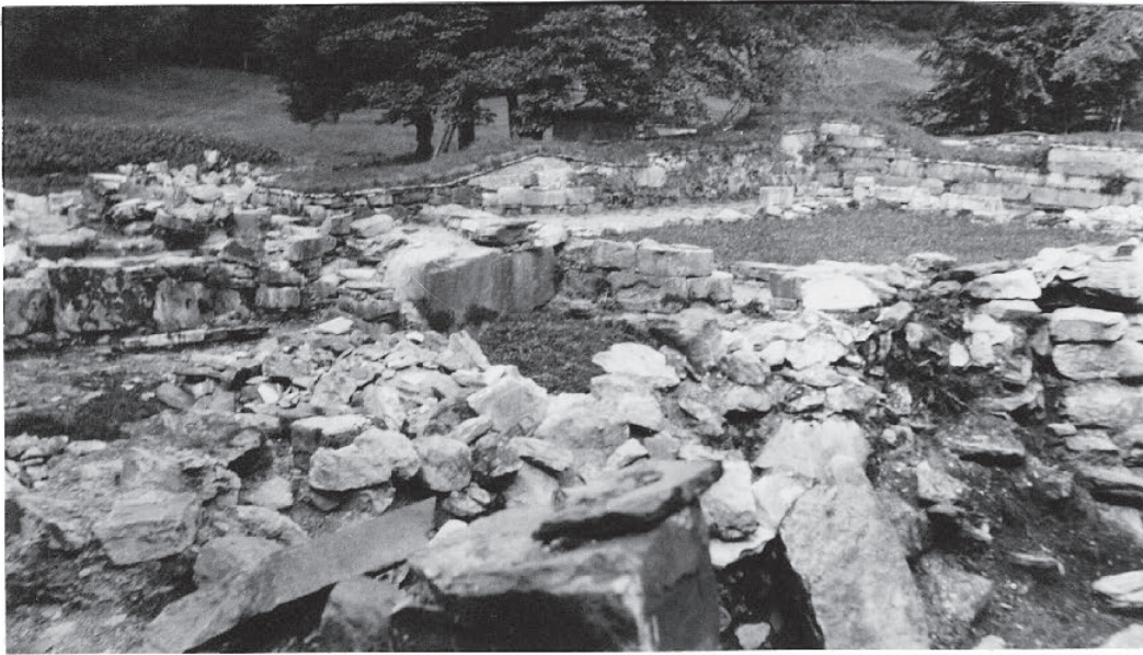
Fig. 177: Foto fra 1920-årene. I forgrunnen refektoriet og skillemuren mot trapperommet, sett fra s/ø. Neg. Riksantikvaren.
