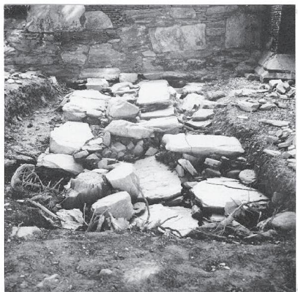
Fig. 184: Det østre fundamentet, sett fra sør.
