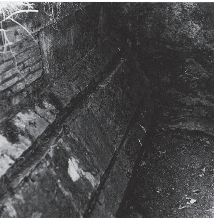
Fig. 106: Kapittelsalen, utvendig hjørne mot rom 5.
