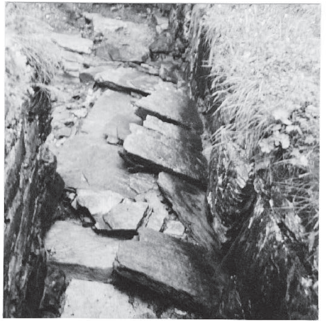
Fig. 193: Refektoriet, vestmurens fremstikkende fundament, sett fra nord.
