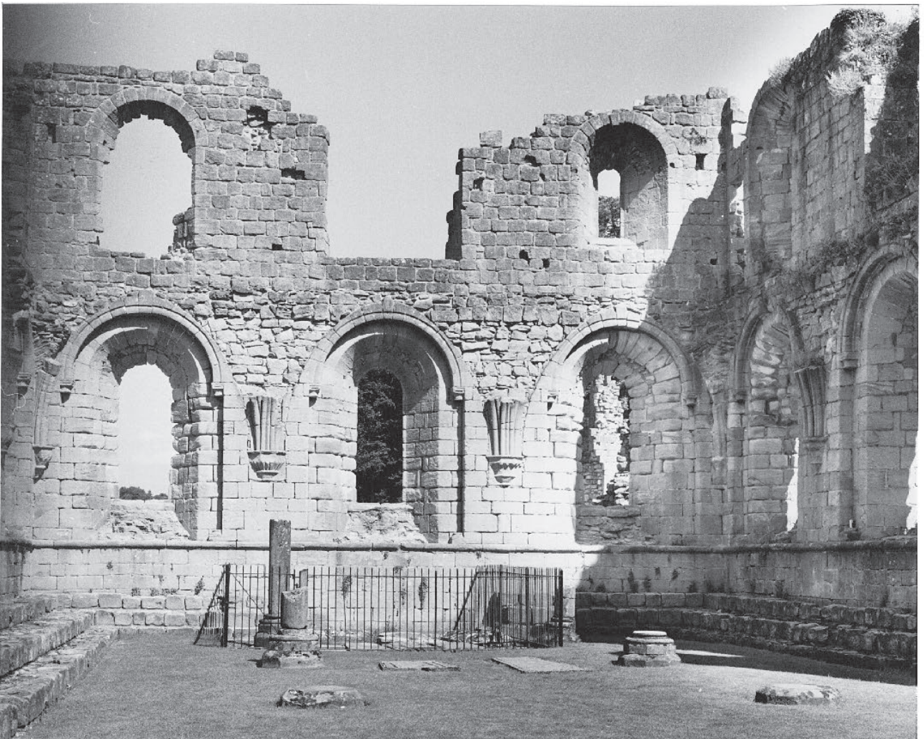
Fig. 130: Fountains, kapittelsalen, interiør, østre del.
