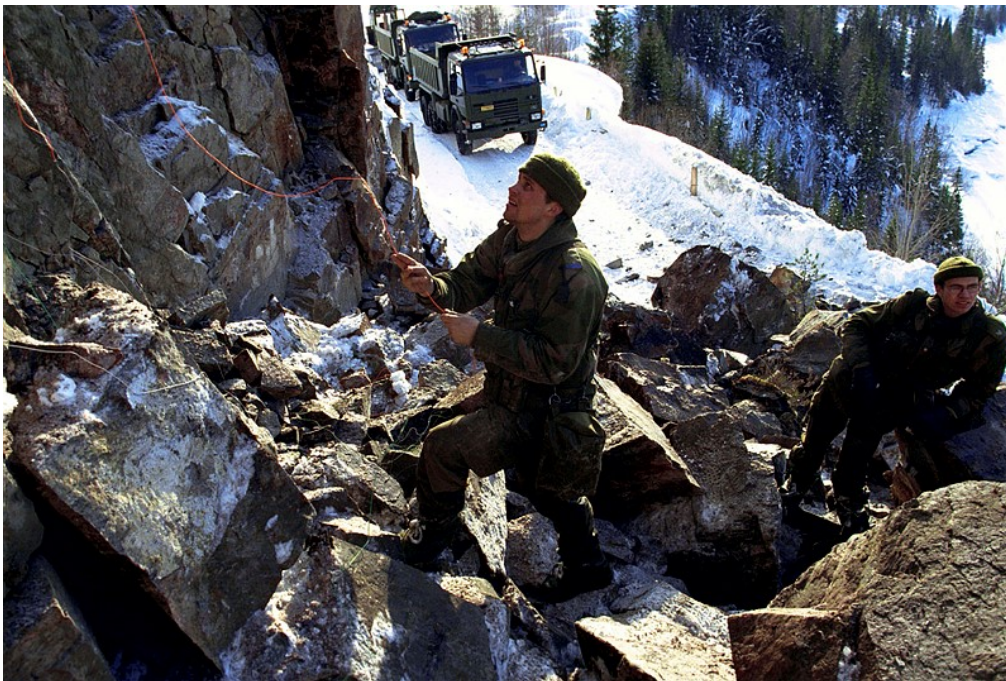
Figur 40. Sprengningsarbeid under vinterøvelse 'Battle Giffin99' (Foto: Torgeir Haugaard/Forsvaret)
