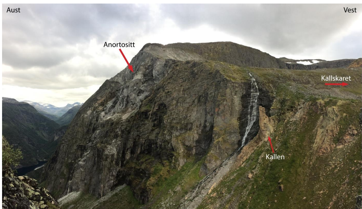
Figur 2.5: Utsikt mot deler av losneområdet til Kallskarskredet. Anortositt kan kjennast att i fjellveggen på den lyse fargen. I forgrunn står Kallen rakk i ryggen, ei søyle av olivinstein. Olivinsteinen ser ein mykje meir av innover Kallskaret. Foto: Mari Sæbø.
