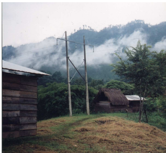
Figur 3.1: Kontraster i Chiapas: høyspentledning som passerer en landsby uten strøm
