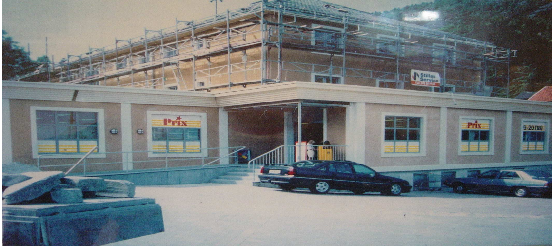
Foto 11. Ombygging til sambrukshus ("prixen" i forgrunnen)
