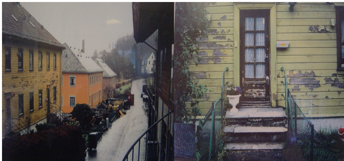
Foto 12 og 13. Nedslitte hus før prosjektstart
