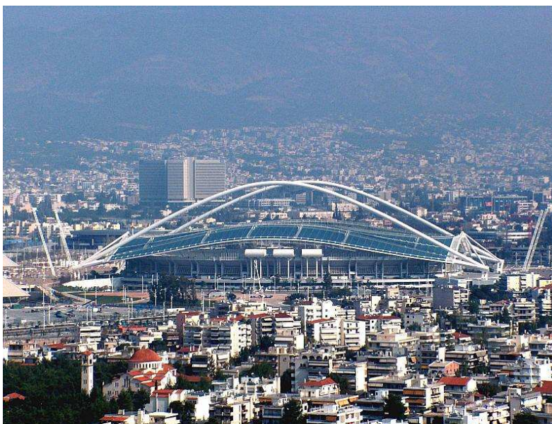
Fig. 25: Olympiastadion har ein høg profil.
