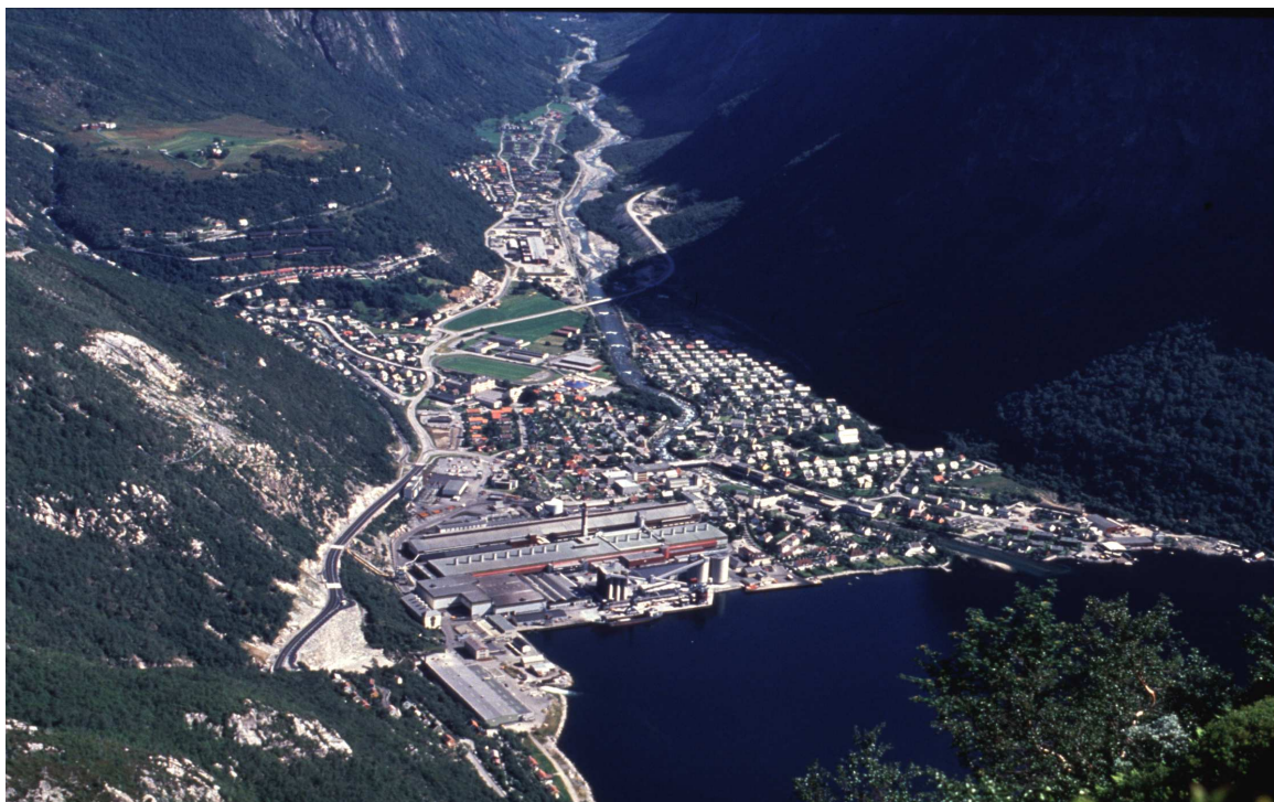
Fig. 2.3. Høyanger 2005 (Høyanger Næringsutvikling).
