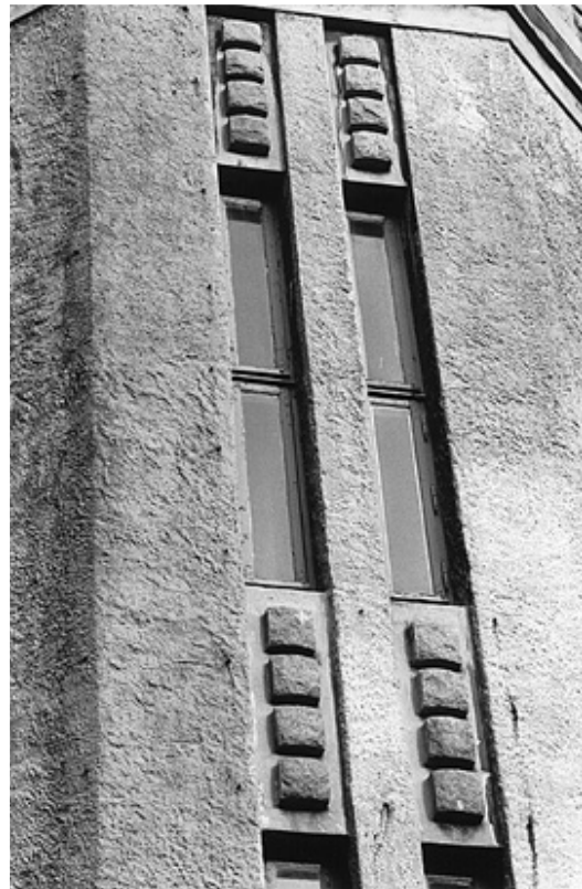
014. Vindusfelt på scenehusets trappetårn. Sammenstilling av natursteinskvadrater og grov og fin puss.
