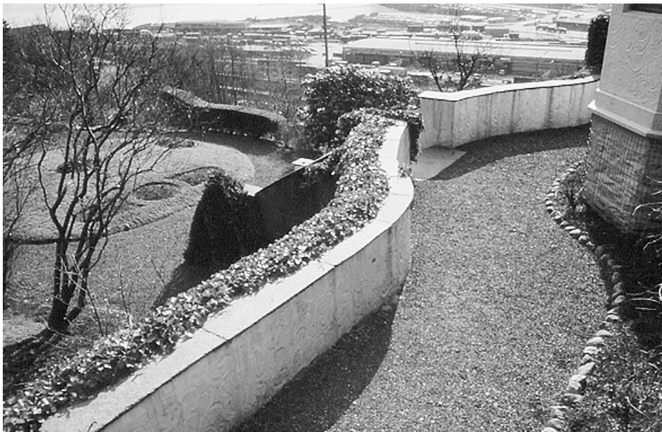
128. Hagen i Kalfarveien 16a.
