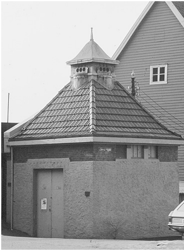
083/084. Fotografi og tegning av transformatoriosk type 1 for Bergens Elektricitetsverk. Fotografi fra Ludebryggen, i dag noe endret.
