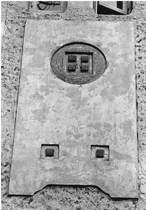
013. Ornamentikk i de vertikale vindusfeltene på tilskuerhusets sidefasade, med differensierte pussstrukturer.
