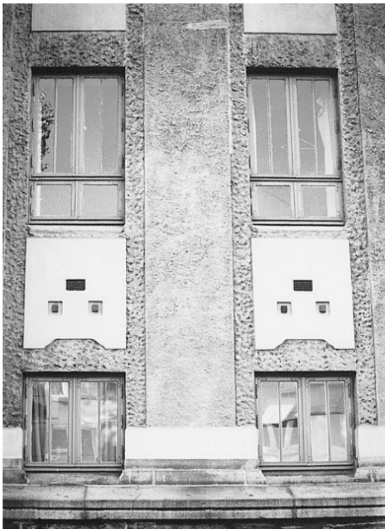
012. Vertikale vindusfelt på scenehusets sidevegg. Viser sammensetning av ulike pusstrukturer.
