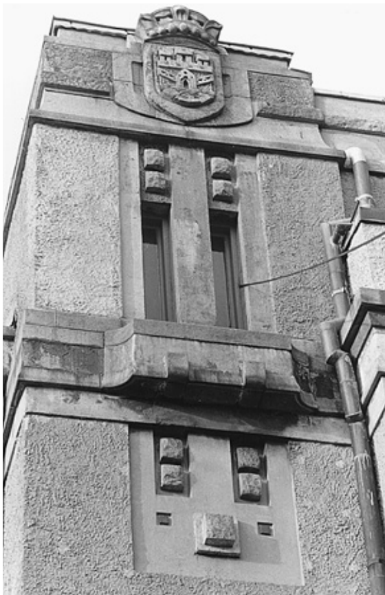
015. Ornamentfelt med geometrisk dekor på hovedfasaden. Kombinasjon av tegl, grovhuggen naturstein, finhuggen kleberstein, og grov og fin puss.
