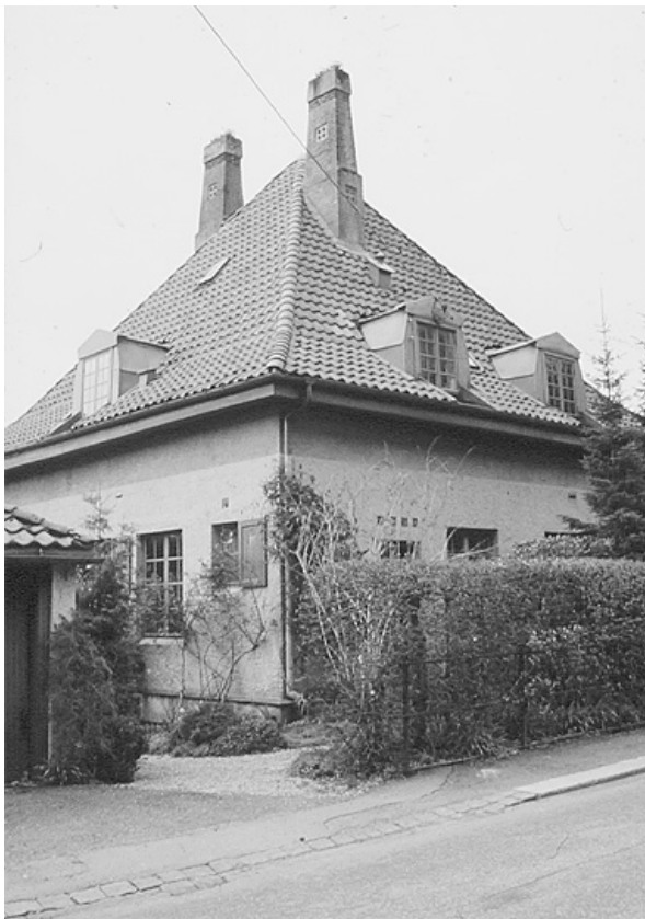
057. Fasade mot øst og nord.
