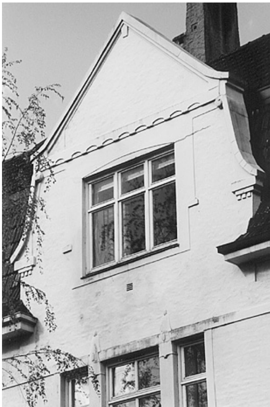
123. Allégaten 57a. Detalj av gavl på østfasaden.
