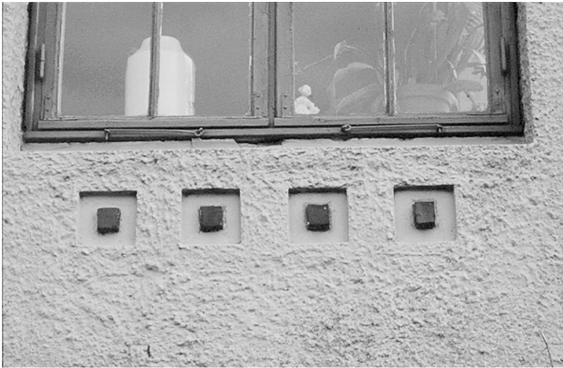
060. Geometriske ornamenter under vindu på sydfasaden. Opprinnelig en av verandaåpningene.
