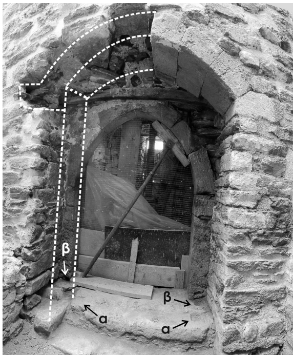
Εικόνα 6: Το τοξωτό θύρωμα του δυτικού ενετικού τοίχου του ισογείου. Το υπερυψωμένο περιθώρωμα και οι τόρμοι για τη στήριξη του θυρώματος (α) ανήκουν στην α' κατασκευαστική φάση, ενώ το χαμηλό περιθώρωμα με τους τετράγωνους στροφείς (β) ανήκει στη β' φάση.
