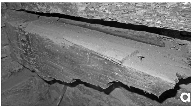
Εικόνα 9: α) Το βόρειο φουρούσι της ανατολικότερης δοκού του πατώματος του ορόφου. Διακρίνονται οι cantinelle ανάμεσα στο φουρούσι και τη δοκό. β) Το νότιο φουρούσι της κεντρικής δοκού του πατώματος του ορόφου. Διακρίνεται το μοναδικό σωζόμενο τμήμα του κοσμητή όπου εδράζεται το φουρούσι.
