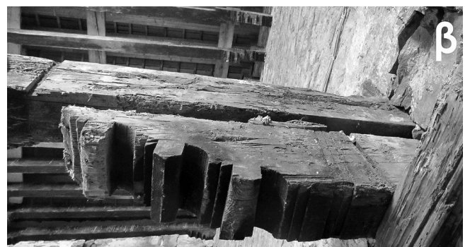
Εικόνα 9: α) Το βόρειο φουρούσι της ανατολικότερης δοκού του πατώματος του ορόφου. Διακρίνονται οι cantinelle ανάμεσα στο φουρούσι και τη δοκό. β) Το νότιο φουρούσι της κεντρικής δοκού του πατώματος του ορόφου. Διακρίνεται το μοναδικό σωζόμενο τμήμα του κοσμητή όπου εδράζεται το φουρούσι.
