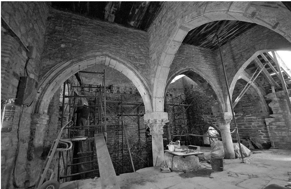
Εικόνα 2: Άποψη του εσωτερικού του κτηρίου με την ενετική loggia και τα εγκάρσια οθωμανικά τόξα.
