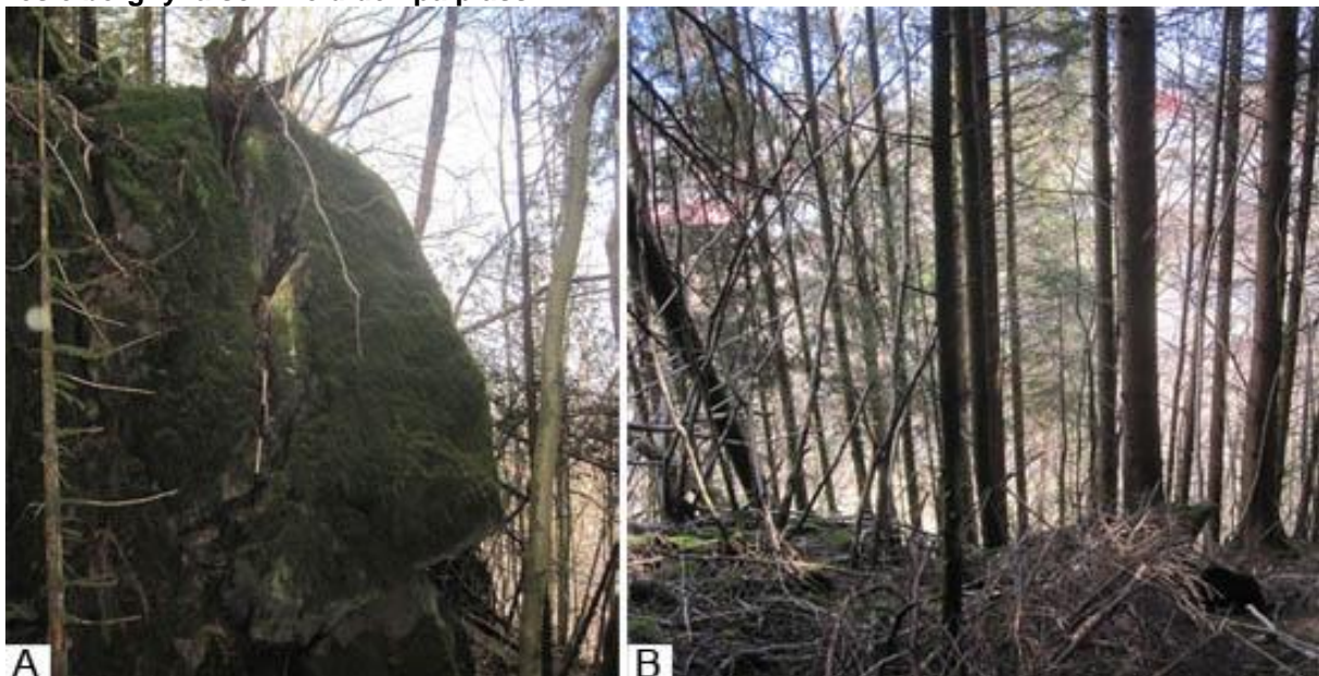
Figur 4-11: (A) Sprekker i bakkant av laus blokk. (B) Skråninga med tett granskog under blokka
