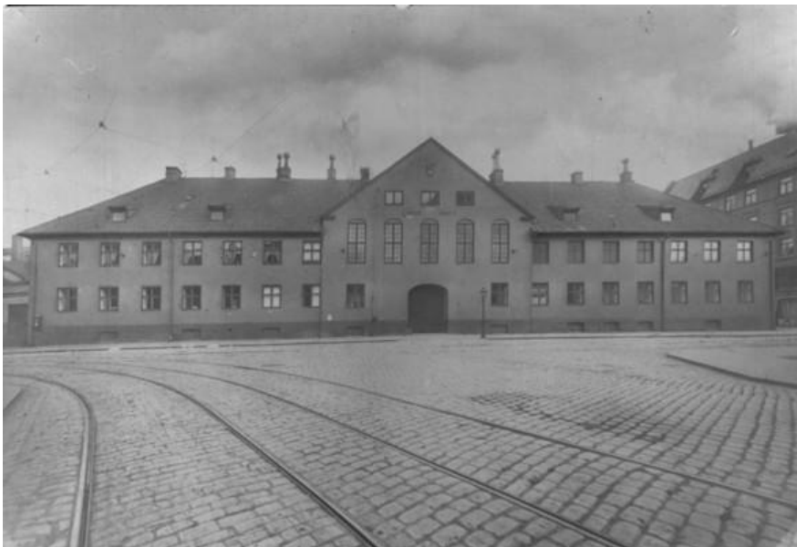
Fasaden på Tukthuset, som det ble kalt på folkemunne, ut mot Storgata (1900). 135 Dette bygget ble brukt til kontorer og boliger for de ansatte, og bak de høye vinduene i andre etasje på midten lå fengselskirken. 136
