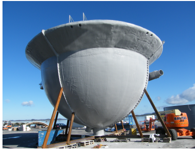
Bilde 2: Aquadom før sjøsetting. På sidene sees inntaksrørene.
