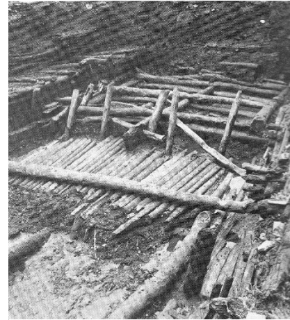
Figur 4.16. Oppbygging av fronten foran rekke 1 Atlegard og Søstergården nord, med bolverksskar, tømmerstokker og stolper. Bildet er tatt fra nordøst (Herteig 1991:60).
