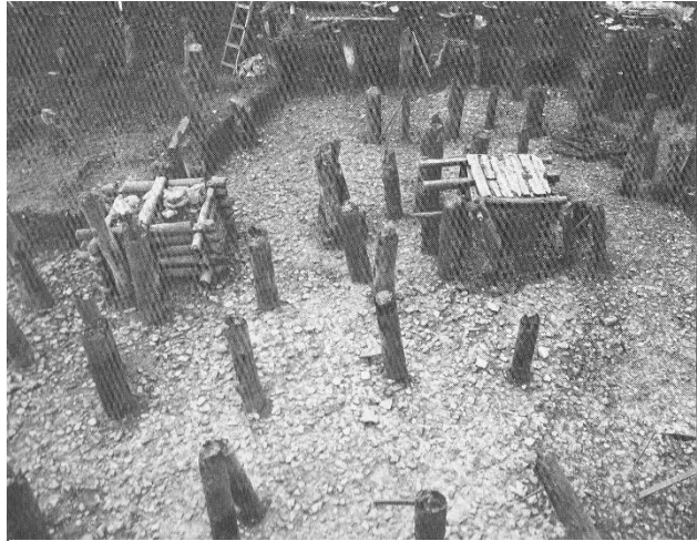
Figur 4.4. Småstein fra det opprinnelige strandområdet fra periode 1, med stolper og kar oppført som fundamenter i periode 2 (Herteig 1991:111).
