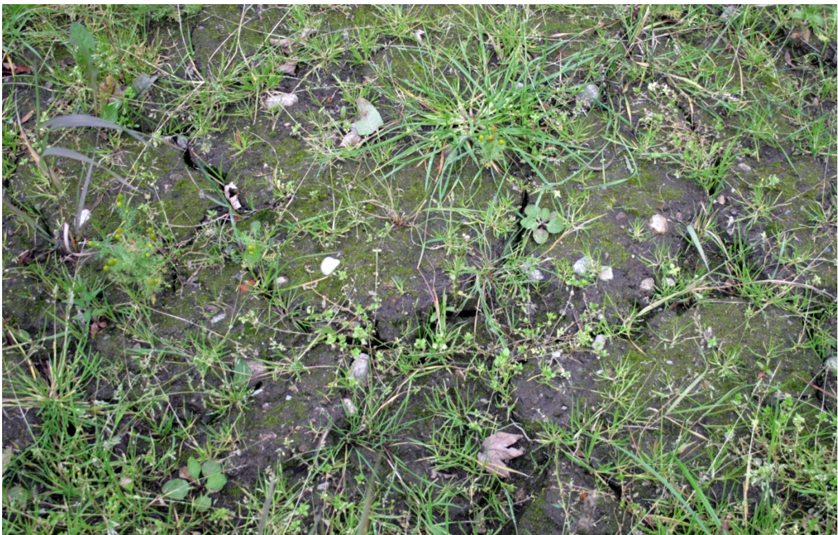
Figur 20: Krakeleringar i leirjord på felt 3 der det tidlegare har vore flateavdekking. Biletet er frå september 2013. Den skrinne vegetasjonen og mangelen på røter i undergrunnen gjer at jorda lettare sprekk opp i tørre periodar.
