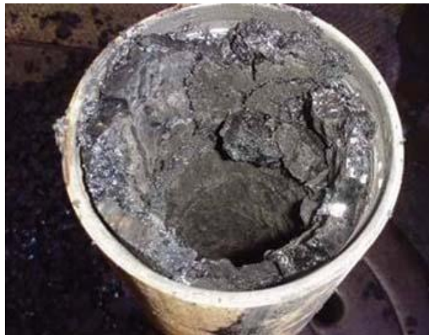
Figur 1.5.4.1: Asfalten-avsetjing i røyrleidning [43].
