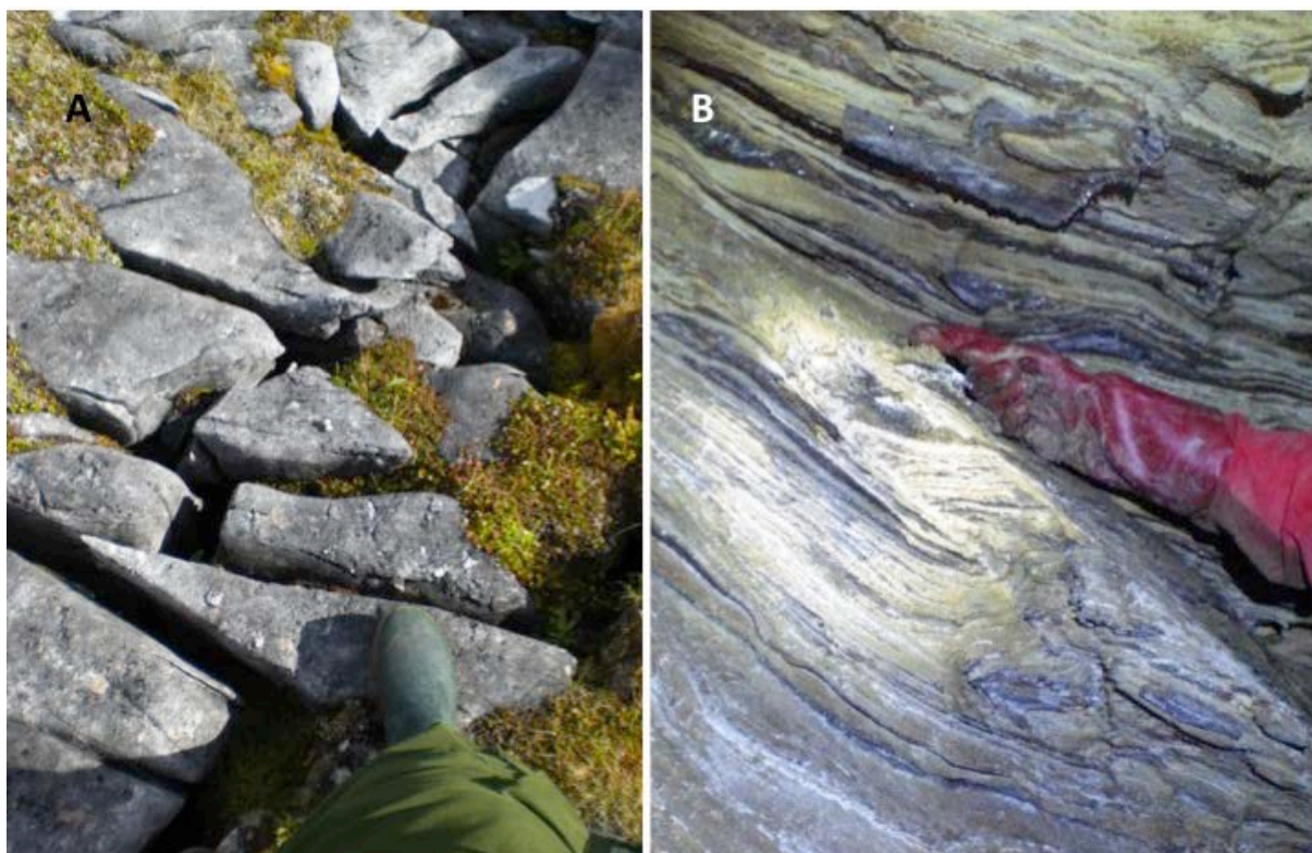
Figur 4. 20 A) Sprekker i marmorlaget på utsiden av grotta omtrent hundre meter nord for Italia-inngangen. Bildet er tatt mot nord. B) Forkastningsflate i Kanonen. Ingen tydelig deformasjonssone.
