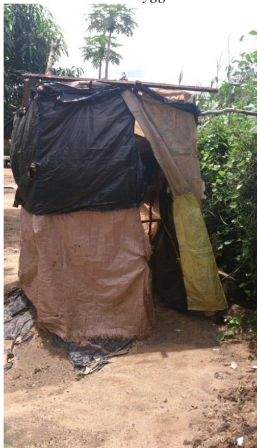
Pit toalett med overbygg
