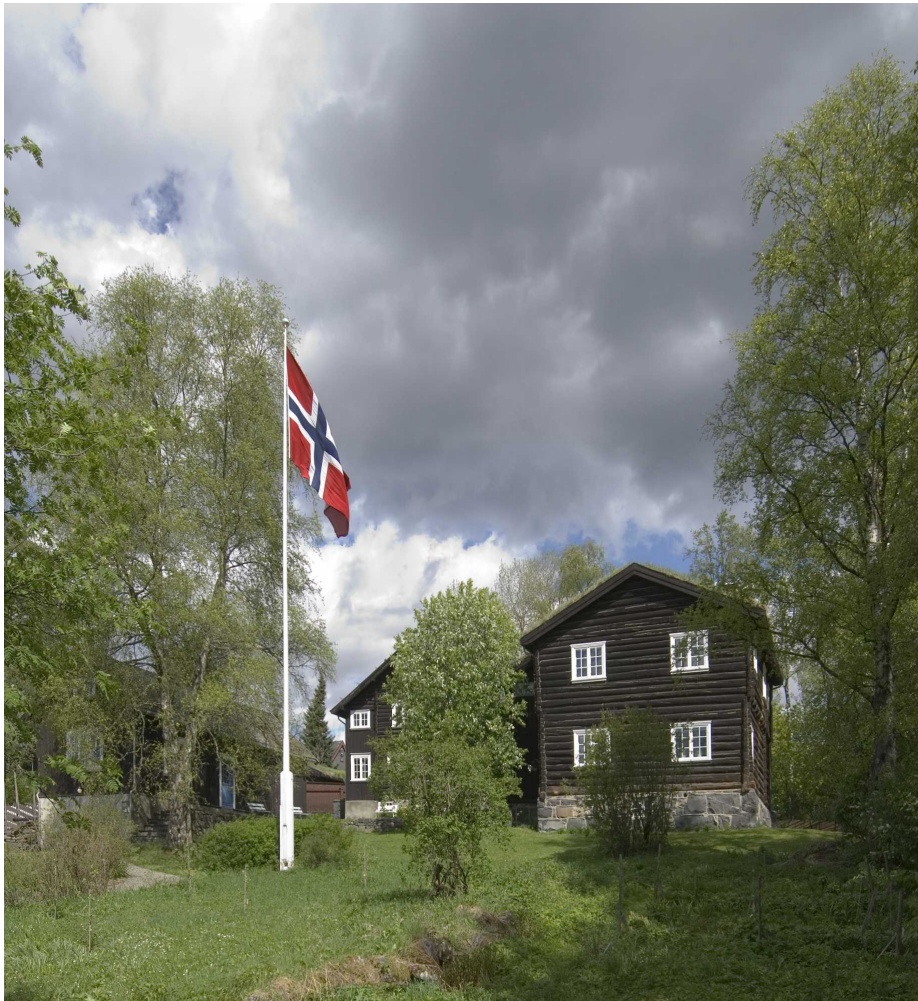
Fig. 8. Bjerkebak sett fra hagen (Jan Haug/Bjerkebak, 2007).
