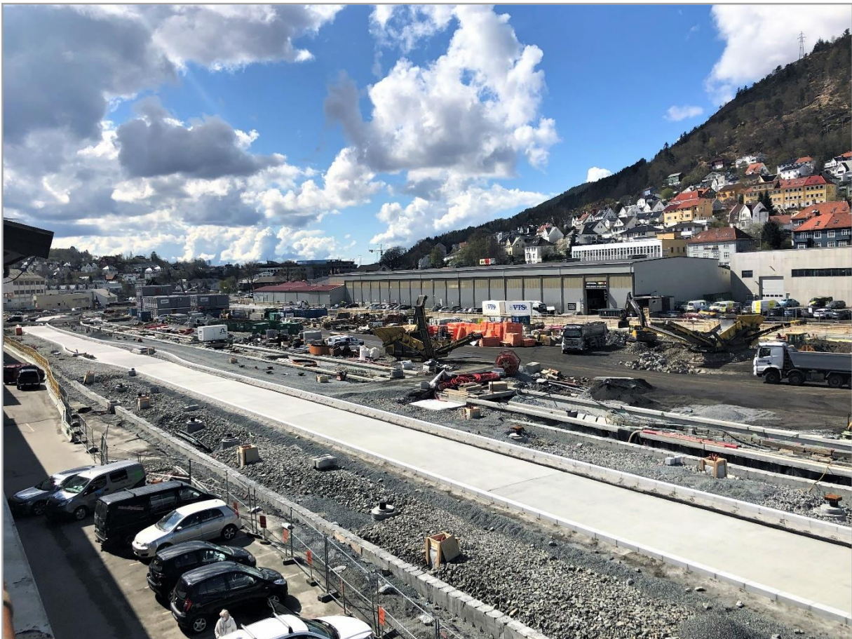
Figur 9, Bybanetraseen langs Mindemyren sett fra nord-øst.
