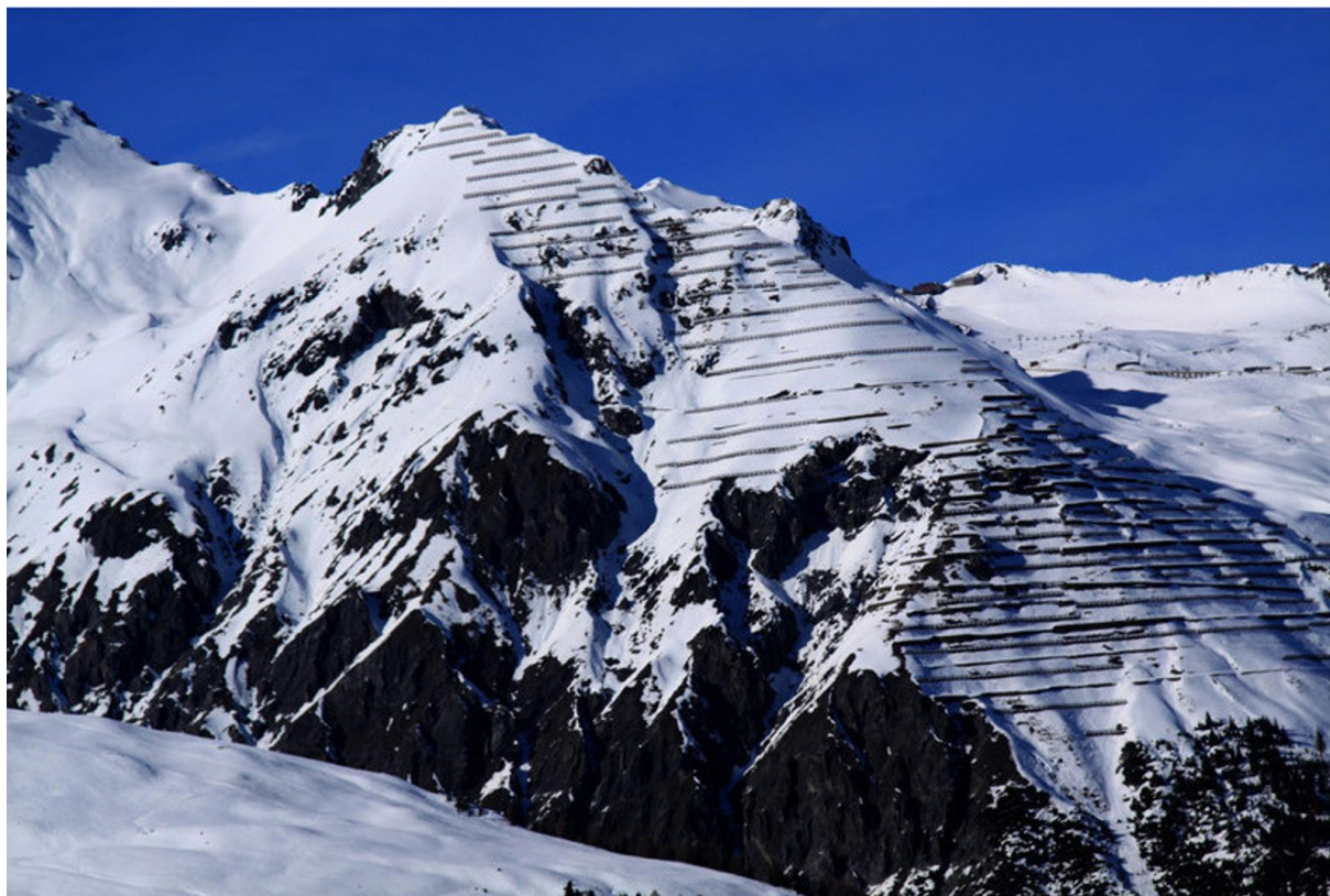
Figur 41: Sikringstiltak mot snøskred med kontrollbarrierer, i fjellet over Davos, Sveits (Foto: Andersson, 2010).
