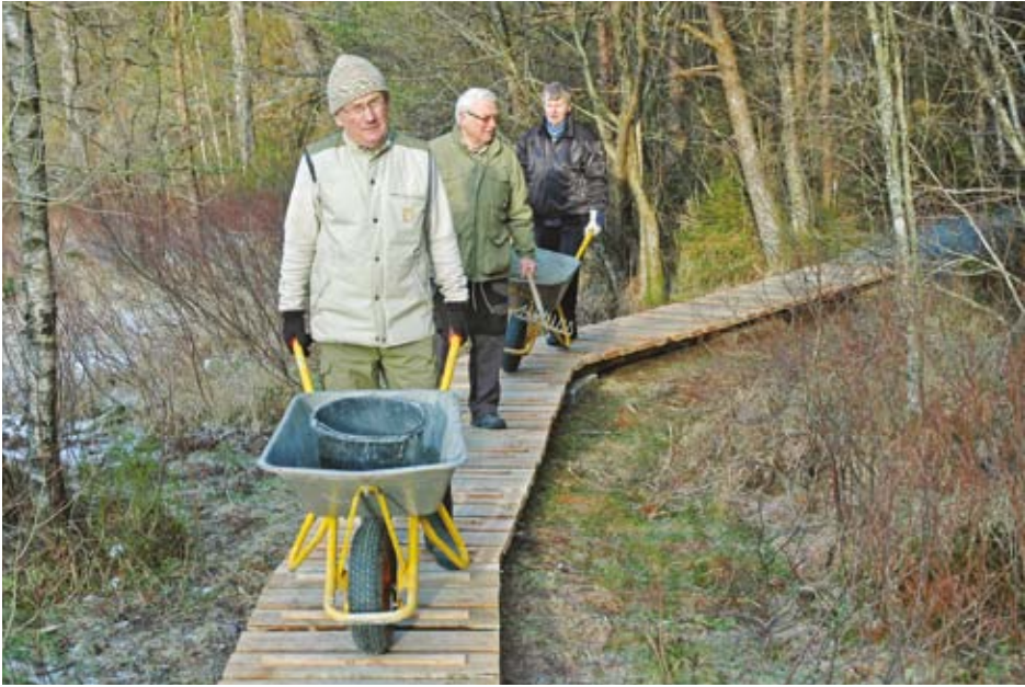
Dugnadsgjengen ved Fredrik M. Sørvig (foran), Olaf Hammersland og Joar Fossland på den nyanlagte gangbroen ved Mørkevatnet (foto: Bjørn Moe 30.01.2012).
