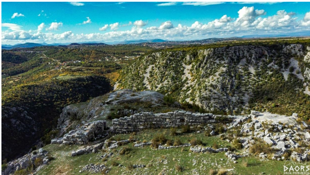
Figur 18: Forsvarsmuren med to tårn og inngangsporter på sidene (Daors Dron, E. Rahic).
